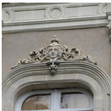
Un linteau sculpté à l'étage. Phot. Pierre-Bernard Fourny IVR52_20215301292NUCA
