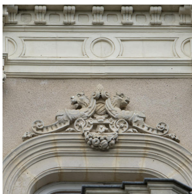
Un linteau sculpté à l'étage. Phot. Pierre-Bernard Fourny IVR52_20215301290NUCA
