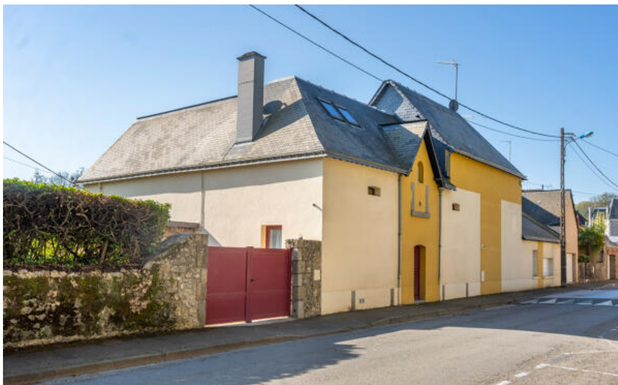
L'ancienne écurie-remise remaniée.
