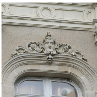
Un linteau sculpté à l'étage. Phot. Pierre-Bernard Fourny IVR52_20215301289NUCA
