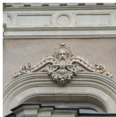
Un linteau sculpté à l'étage. Phot. Pierre-Bernard Fourny IVR52_20215301291NUCA
