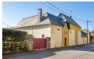
L'ancienne écurie-remise remaniée. Phot. Pierre-Bernard Fourny IVR52_20225300376NUCA
