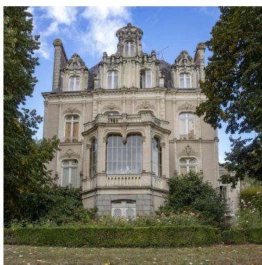
La maison. Phot. Pierre-Bernard Fourny IVR52_20215301294NUCA
