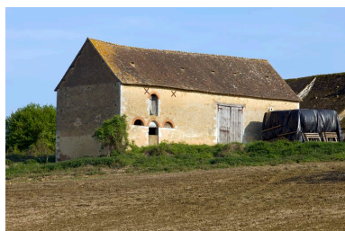
Grange-étable-fenil, vue depuis le nord-ouest. Phot. Yves Guillotin IVR52_20117200514NUCA
