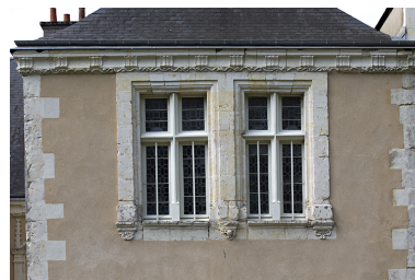
Élévation nord, pavillon d'escalier, détail de l'étage. Phot. Pierre-Bernard Fourny IVR52_20147200210NUCA
