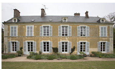
Élévation sud-ouest. Phot. Pierre-Bernard Fourny IVR52_20147200214NUCA
