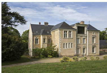
Élévation nord-est. Phot. Pierre-Bernard Fourny IVR52_20147200208NUCA
