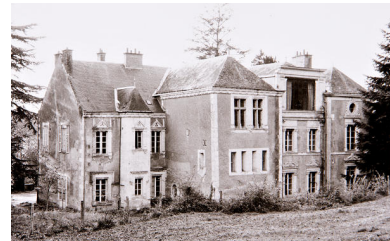
Vue de volume avec élévation nord-est. Phot. Pierre-Bernard Fourny IVR52_20177200273NUCA
