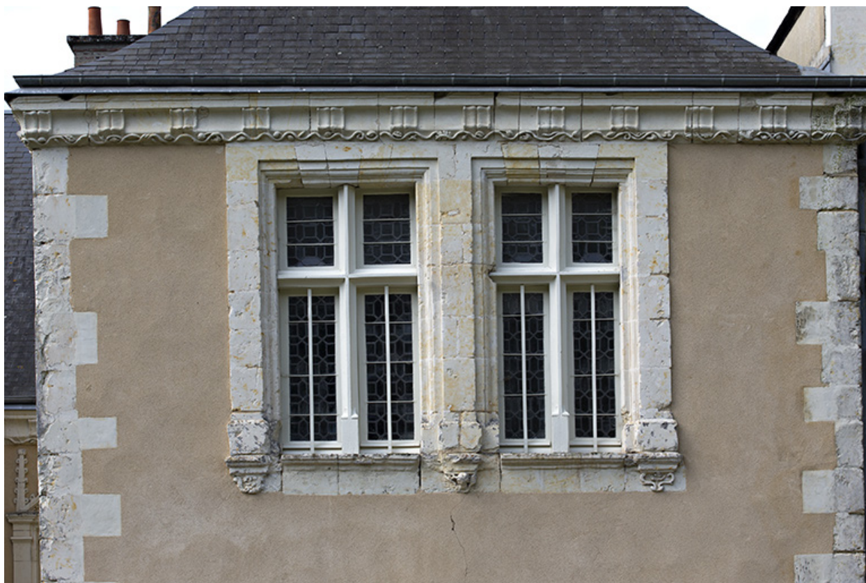
Elévation nord, pavillon d'escalier, détail de l'étage.
