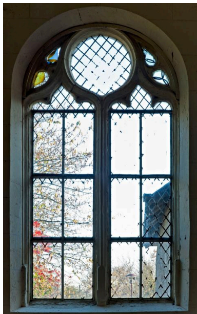
Verrière : vue générale. Phot. Jean-Baptiste Darrasse IVR52_20117201563NUCA
