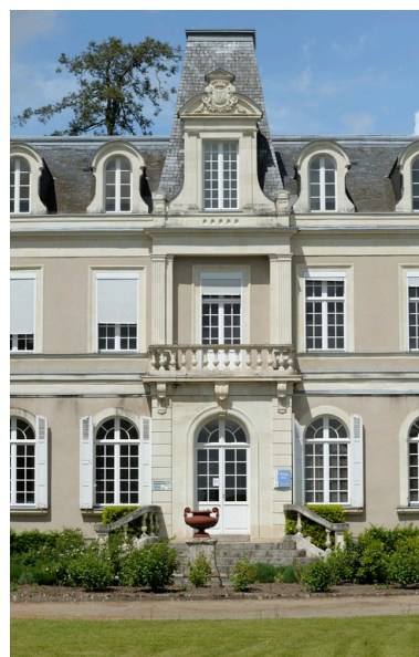
Détail de la travée centrale de la façade sud. Phot. Bruno Rousseau IVR52_20134900626NUCA
