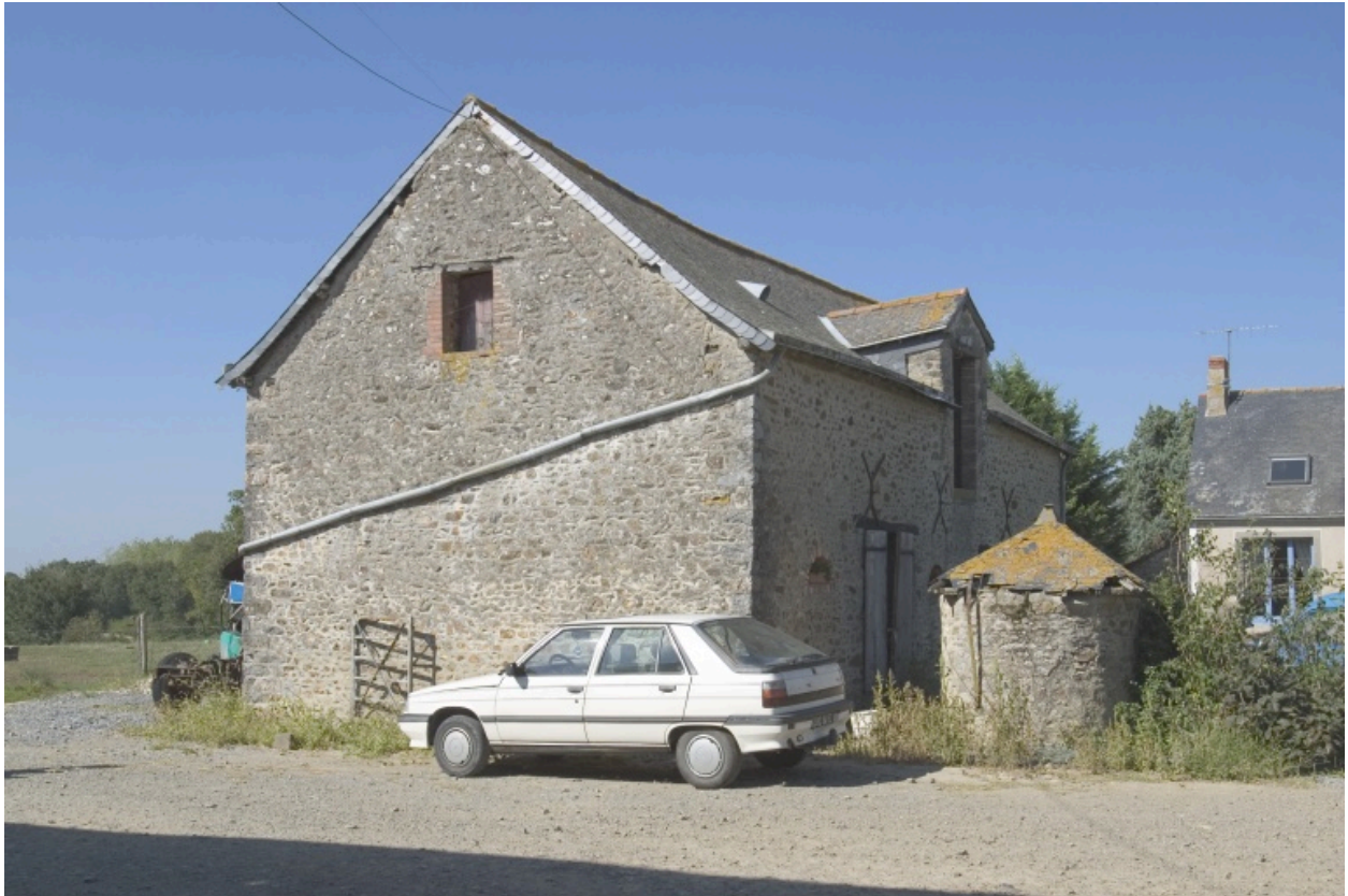
La seconde étable et le puits vus depuis le sud.
