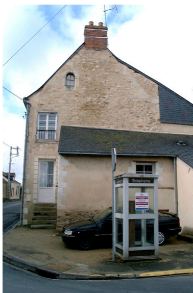
Vue du mur pignon nord. Phot. Ronan Durandière IVR52_20064900727NUCA
