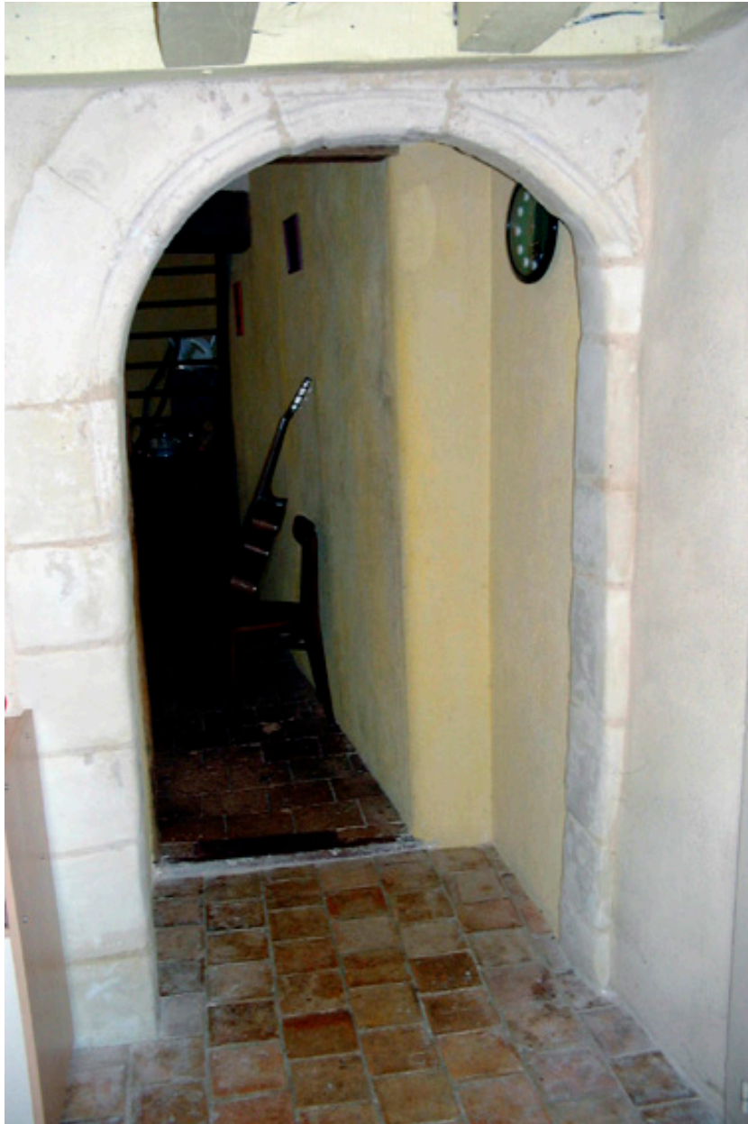
Détail de la porte d'entrée sur le mur pignon nord.
