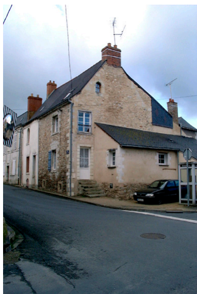
Vue d'ensemble de la maison depuis le nord. Phot. Ronan Durandière IVR52_20064900730NUCA
