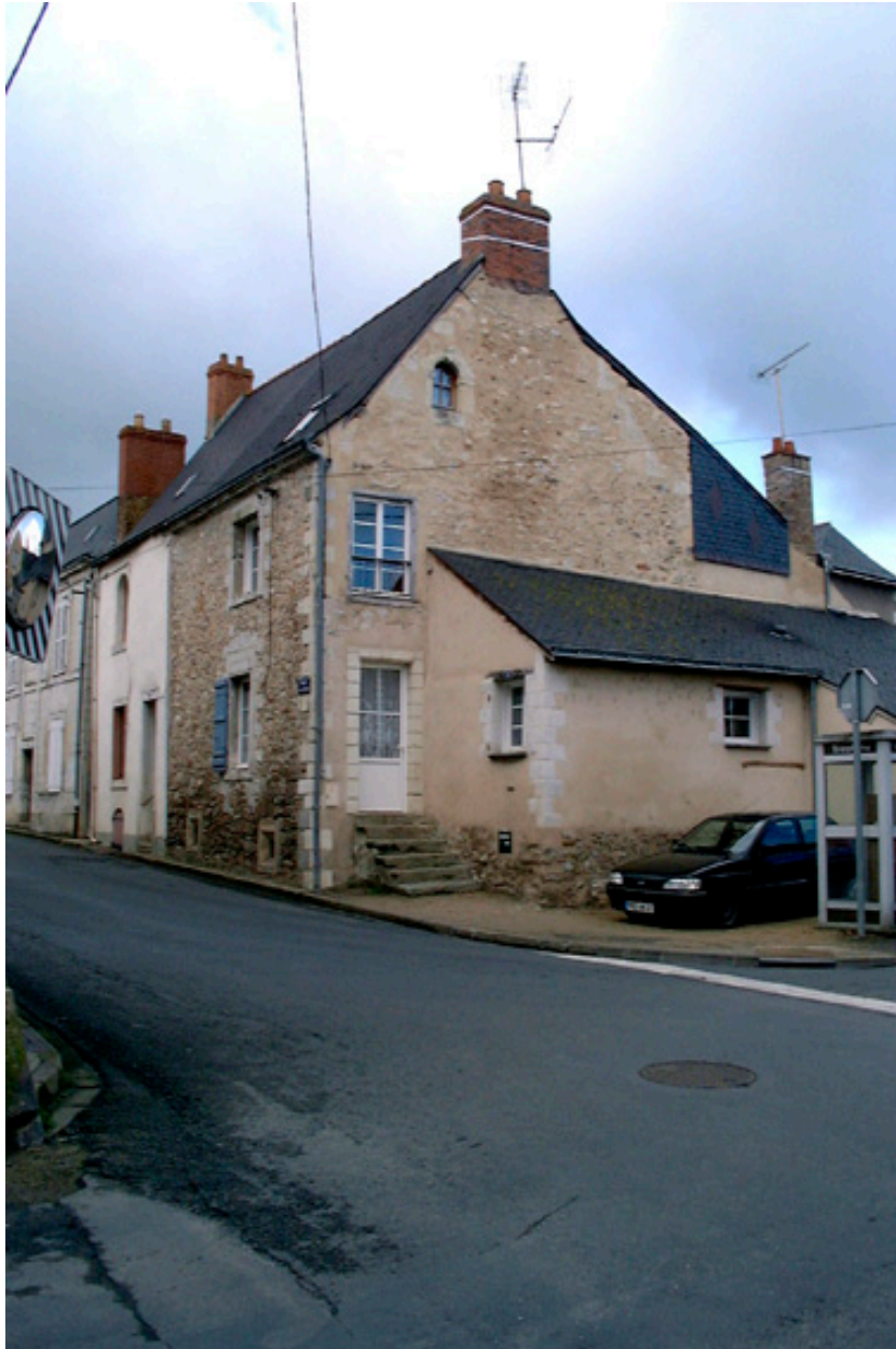
Vue d'ensemble de la maison depuis le nord.
