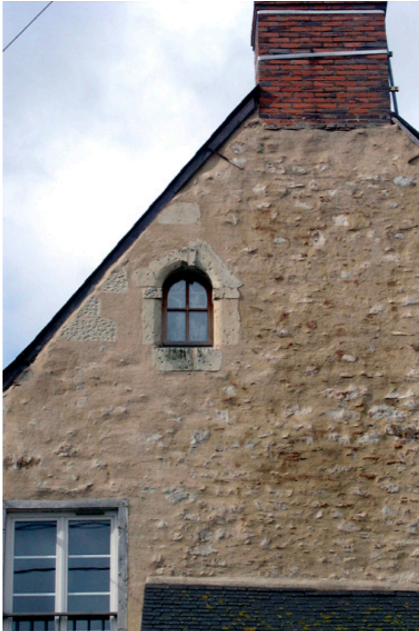
Détail d'un jour couvert en plein cintre percé sur le mur pignon nord.
