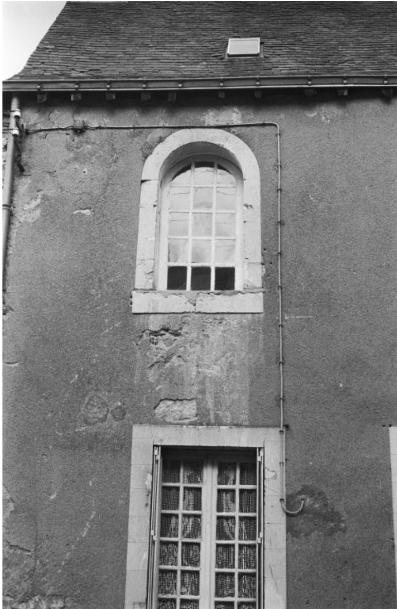
Détail de la façade principale : baie cintrée en tuffeau.
