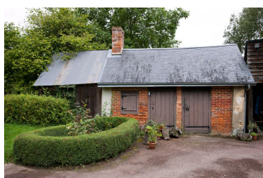
Dépendance. Phot. Yves Guillotin IVR52_20117200155NUCA
