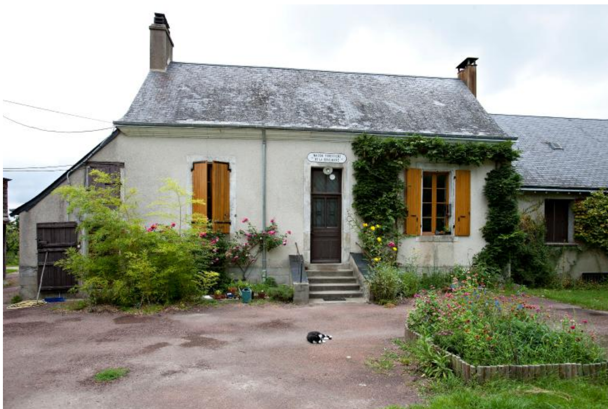
Maison foresti re : fa ade ant rieure sur cour.
