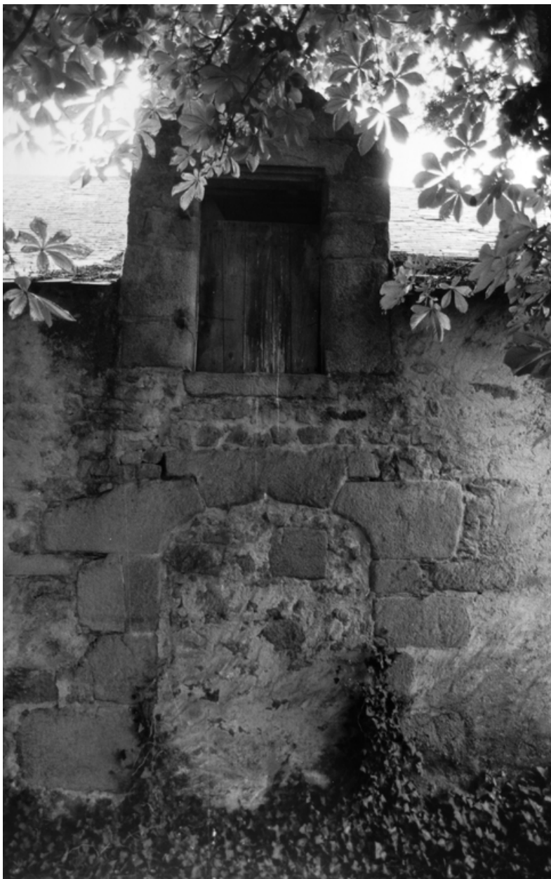
Communs. Détail de la porte et de la lucarne du comble. 1990.
