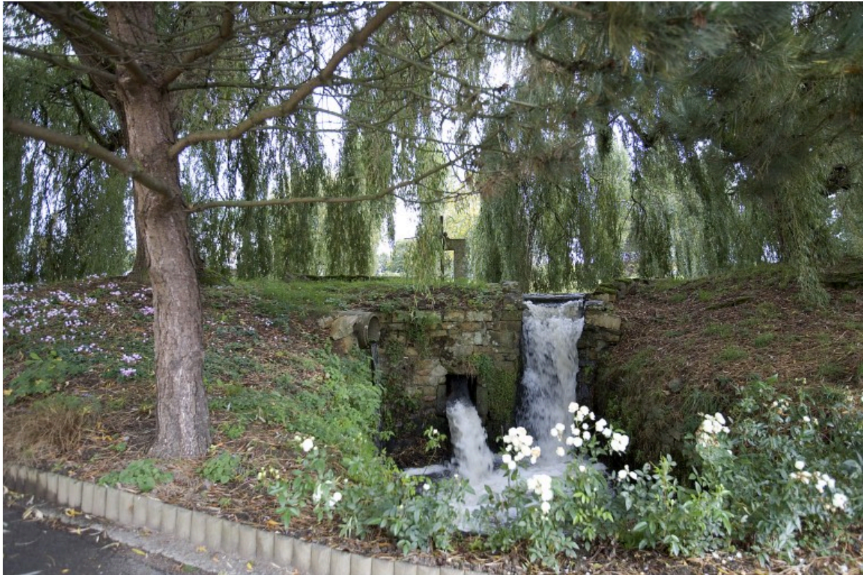
Vestiges de la vanne d'alimentation du moulin et déversoir modernes situés à l'angle sud-ouest de l'étang de retenue.
