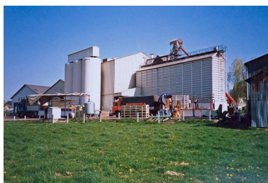
Vue d'ensemble depuis le sud, 1987. De gauche à droite : le bâtiment de stockage des sacs de farine, le bâtiment de l'ensachage, les trois silos à farine, le poste de réception du blé et les silos à blé sale. Autr. Rioux, Repro. François Lasa IVR52_20075300815NUCA
