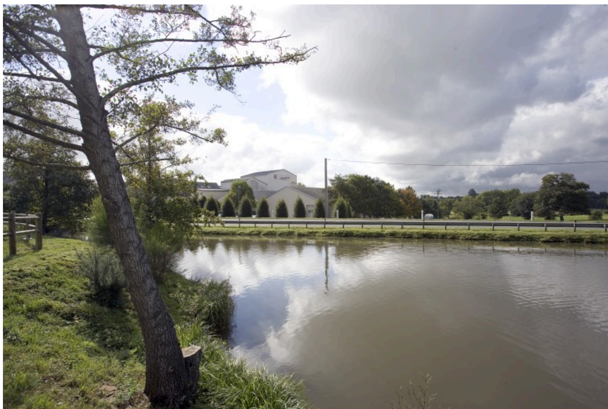
Vue d'ensemble depuis le nord. Au premier plan, l'étang de retenue situé sur le ruisseau de Landelle.
