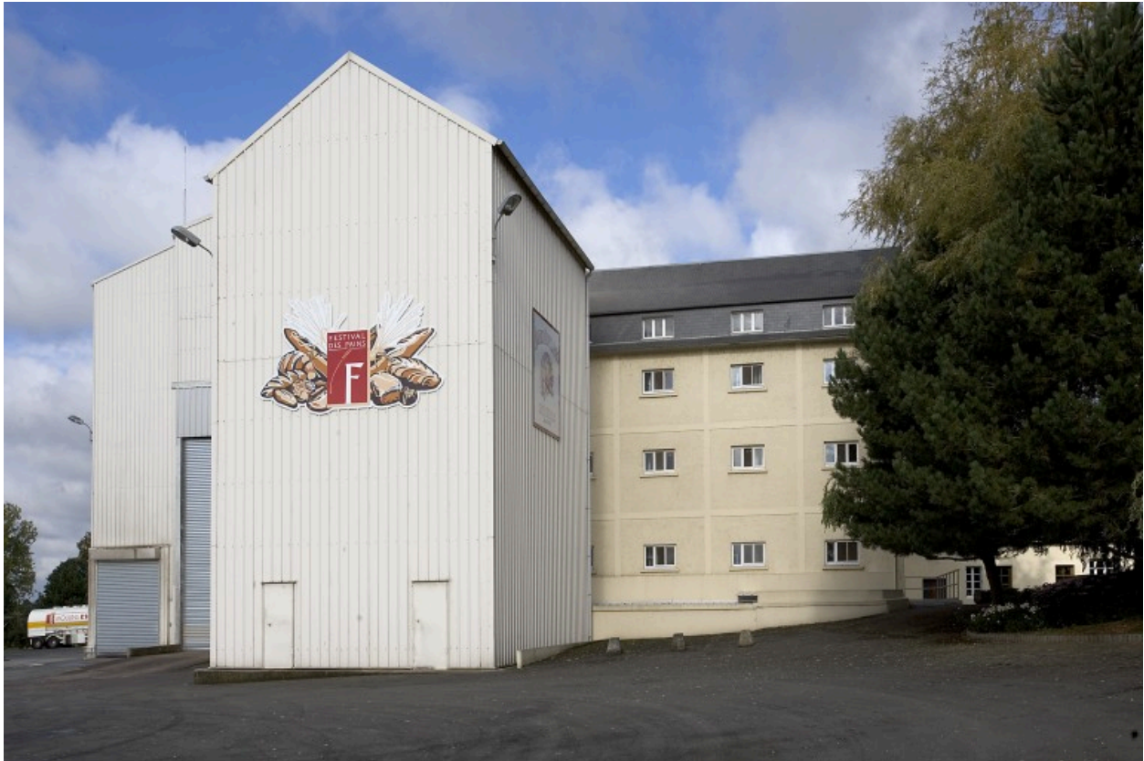
Le bâtiment abritant les silos à blé propre et à blé sale et le bâtiment de la minoterie vus depuis le sud-est.
