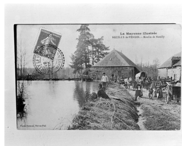
Le moulin et le bâtiment de dépendance, vus de la cour, au nord-est, avant 1910. Autr. Davoust, Repro. François Lasa IVR52_20025300786X
