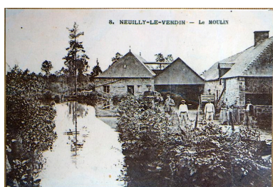
Le moulin et le logis-dépendance vus depuis le nord-est, après la construction du hangar de chargement. Vers 1920. Repro. François Lasa IVR52_20075300814NUCA
