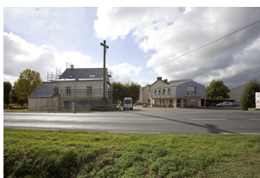
Vue d'ensemble depuis le nord. Au premier plan, l'ancien garage à camions et les bureaux. Au second plan, les pignons de la maison et de la minoterie et, à droite, le bâtiment de stockage des sacs de farine. Phot. François Lasa IVR52_20075300822NUCA
