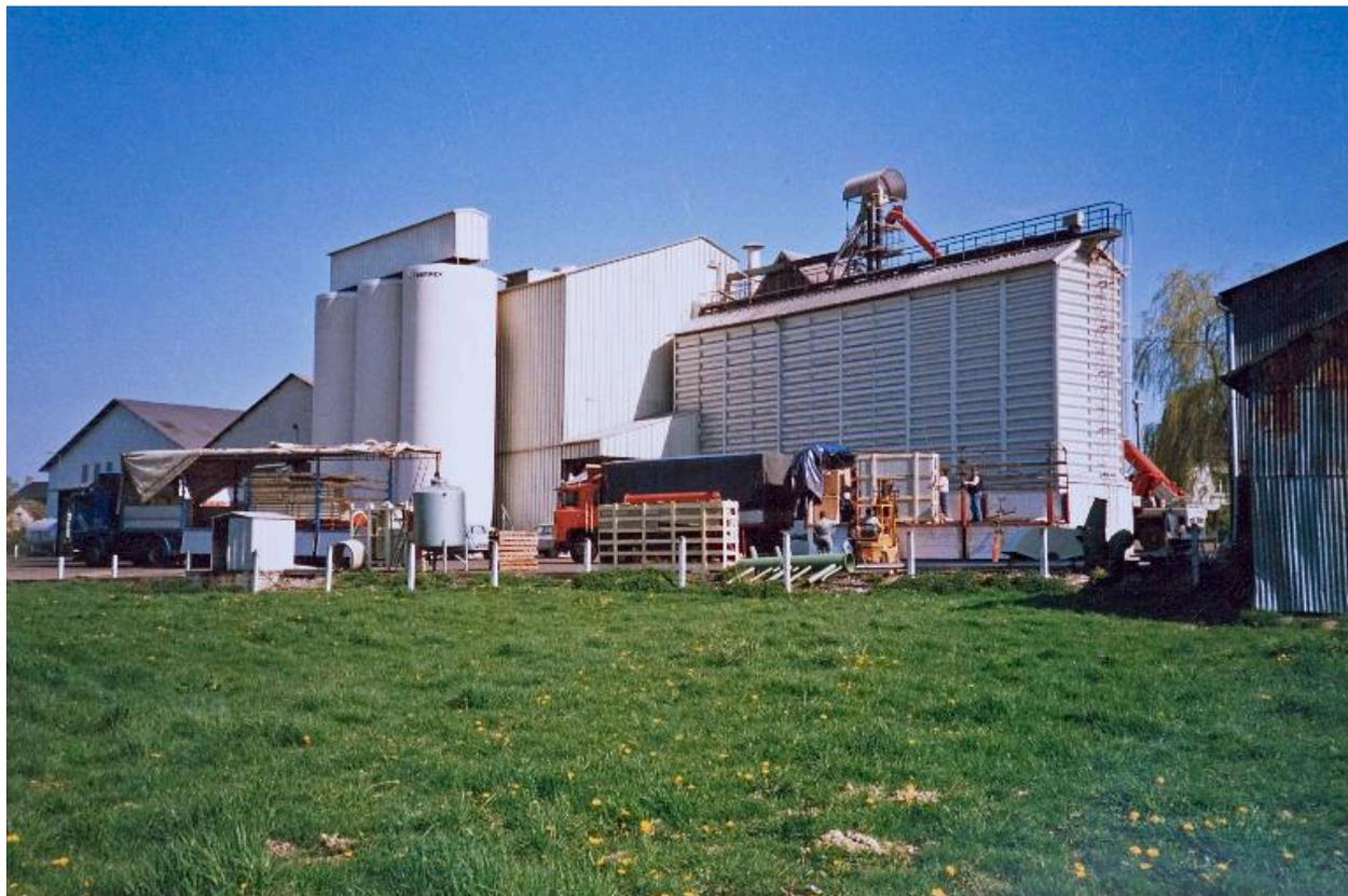
Vue d'ensemble depuis le sud, 1987. De gauche à droite : le bâtiment de stockage des sacs de farine, le bâtiment de l'ensachage, les trois silos à farine, le poste de réception du blé et les silos à blé sale.
