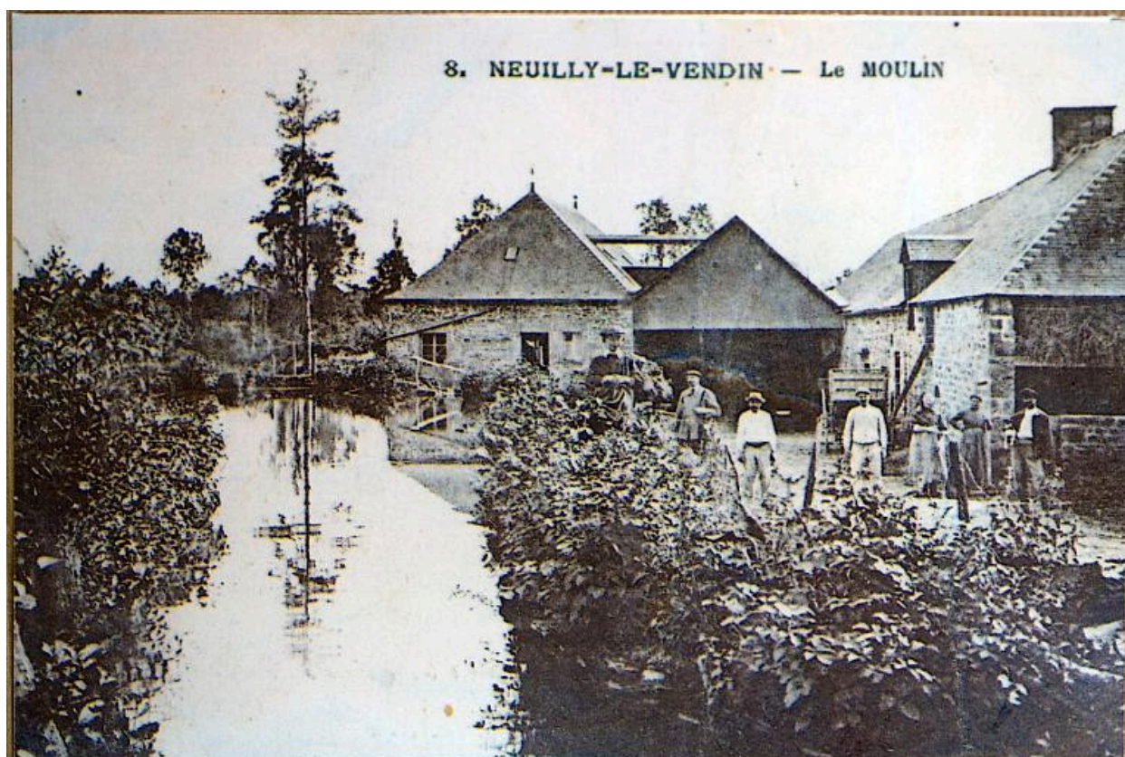
Le moulin et le logis-dépendance vus depuis le nord-est, après la construction du hangar de chargement. Vers 1920.
