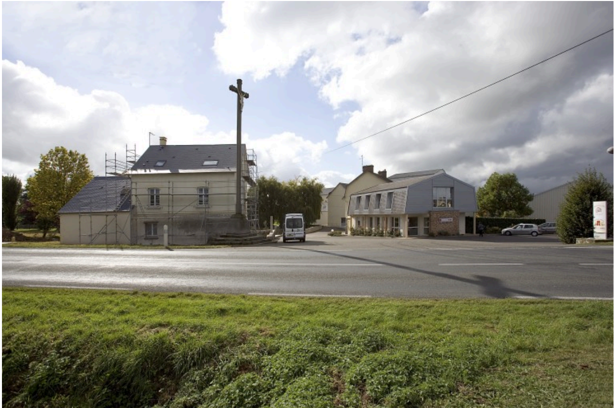
Vue d'ensemble depuis le nord. Au premier plan, l'ancien garage à camions et les bureaux. Au second plan, les pignons de la maison et de la minoterie et, à droite, le bâtiment de stockage des sacs de farine.
