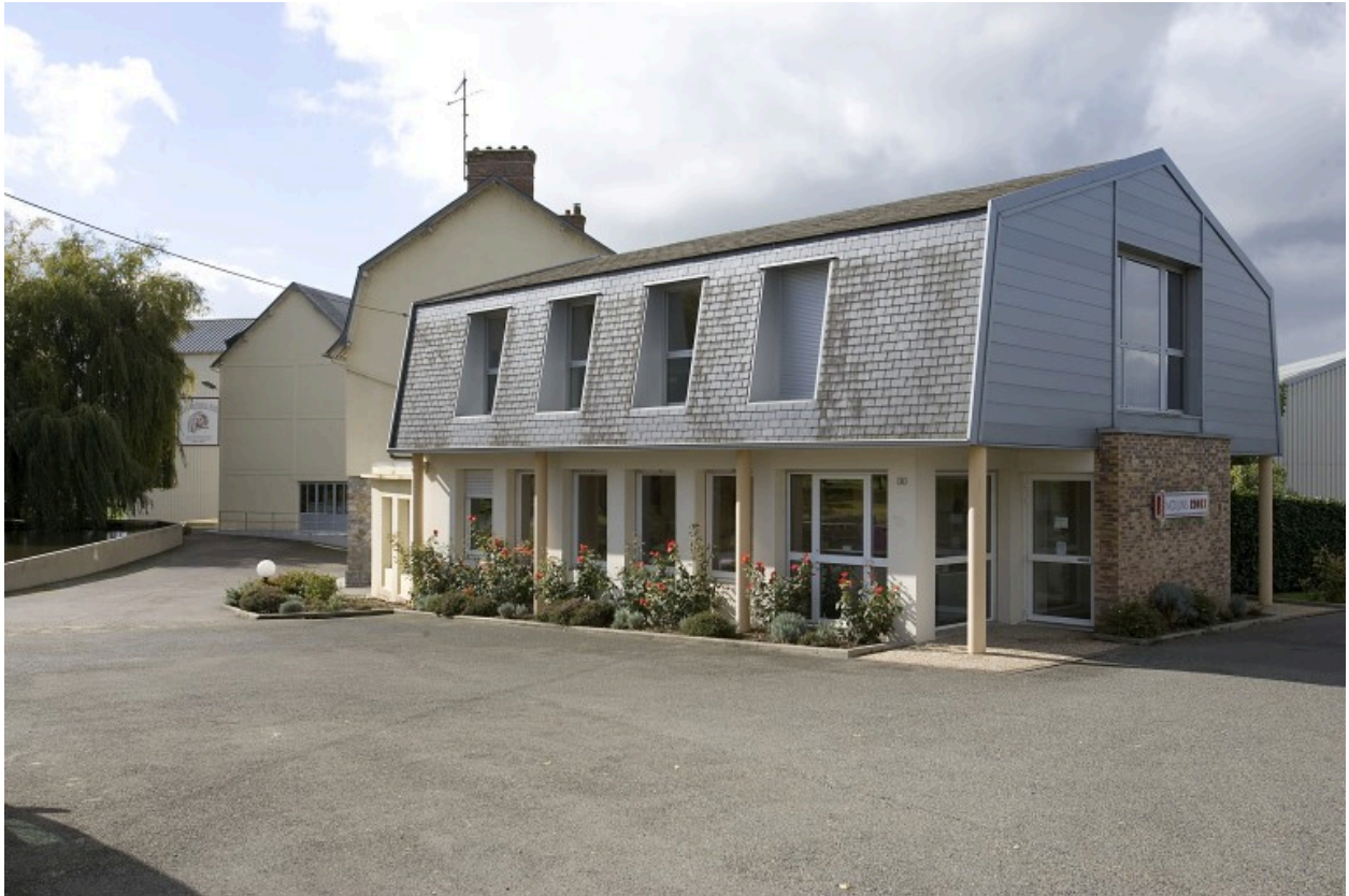
Les bureaux vus depuis le nord-est.
