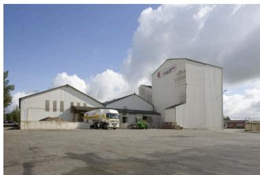
Vue d'ensemble depuis le sud-ouest. De gauche à droite : le bâtiment de stockage des sacs de farine ; le bâtiment de l'ensachage ; le bâtiment abritant le poste d'expédition du son et du remoulage, le poste d'expédition de la farine en vrac et les silos à farine. Au fond, à droite : le bâtiment abritant le fournil et les salles de formation.
