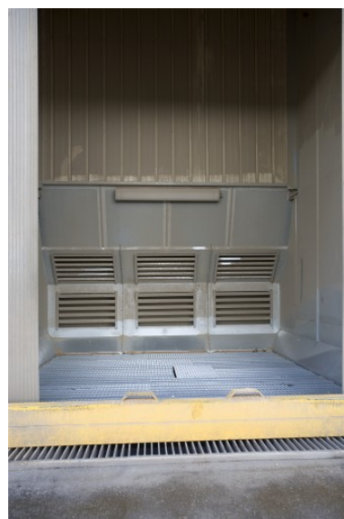
La fosse de réception. Phot. François Lasa IVR52_20075300811NUCA
