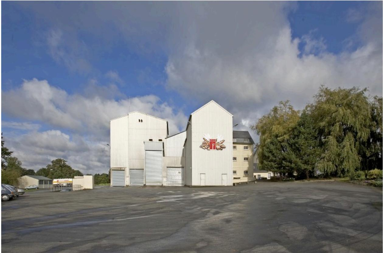
Vue d'ensemble depuis le sud-est. A gauche, le bâtiment abritant le poste d'expédition du son et du remoulage, le poste d'expédition de la farine en vrac et les silos à farine, avec au-devant, la fosse de réception. Au centre, le poste de réception du blé. A droite le bâtiment abritant les silos à blé et, en retrait, la minoterie.
