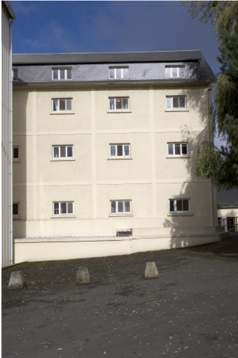
La minoterie vue depuis le sud-est.
