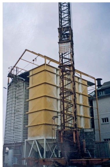
Le montage des quatre silos à blé propre à côté des silos à blé sale, 1993. Autr. Rioux, Repro. François Lasa IVR52_20075300816NUCA
