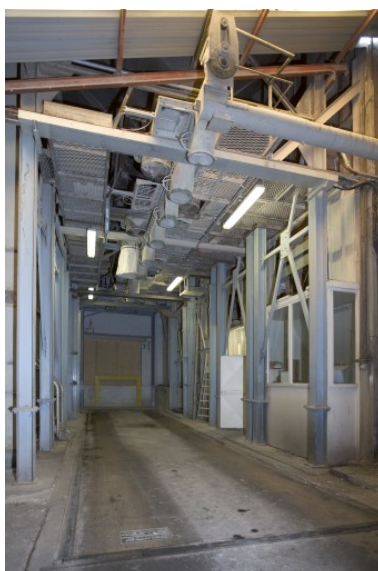
Le poste de réception du blé. Phot. François Lasa IVR52_20075300803NUCA
