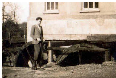
Les roues peu avant leur démontage, 1947. Autr. Rioux, Repro. François Lasa IVR52_20075300812NUCA
