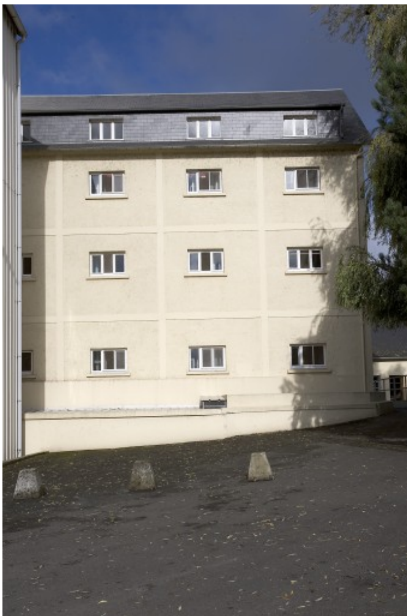
La minoterie vue depuis le sud-est.
