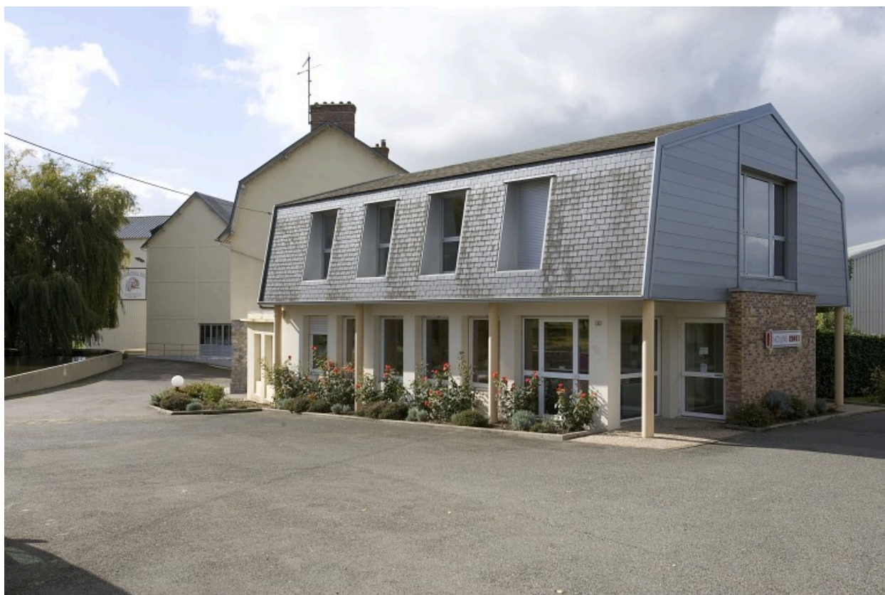
Les bureaux vus depuis le nord-est.
