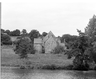
Chevet : vue d'ensemble. Phot. François Lasa IVR52_19825300413X
