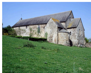
Elévation latérale sud : vue d'ensemble depuis le sud-est. Phot. François Lasa IVR52_20025300610XA
