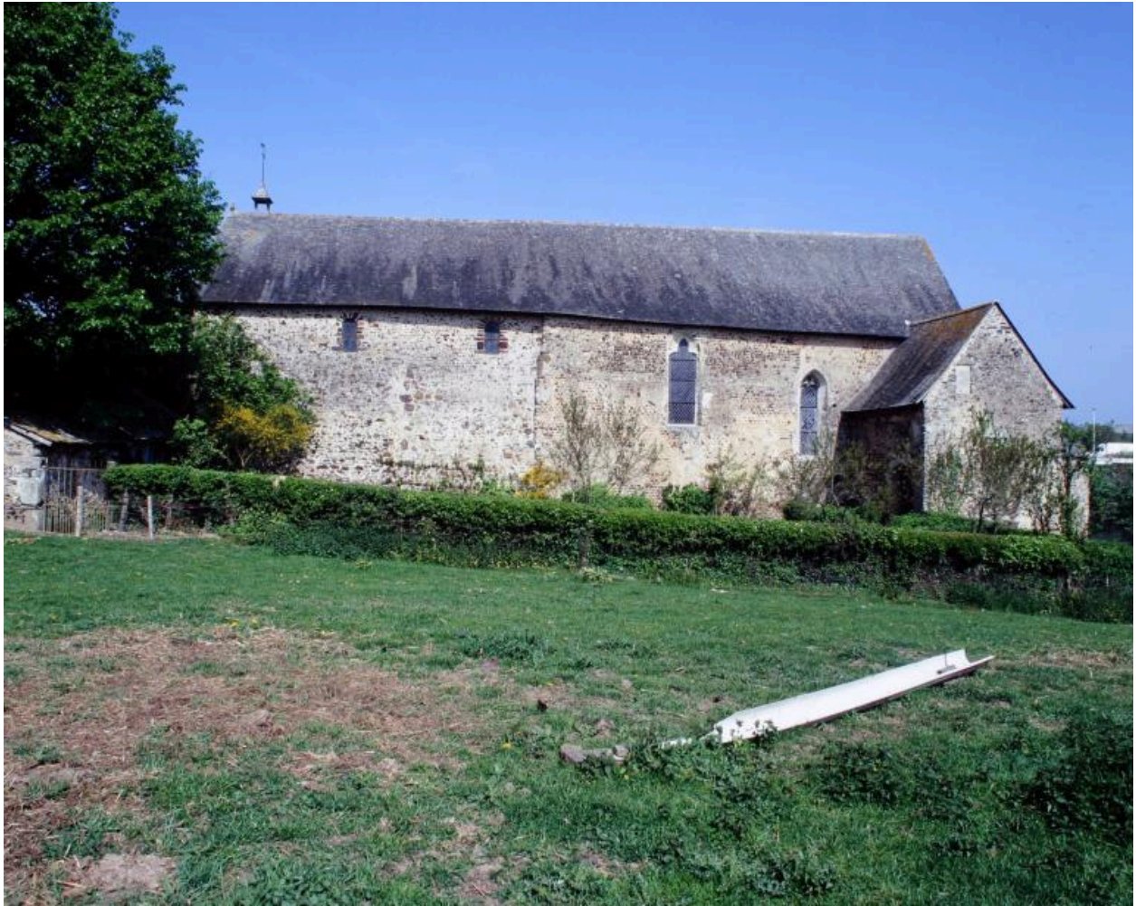
Elévation latérale sud : vue d'ensemble.
