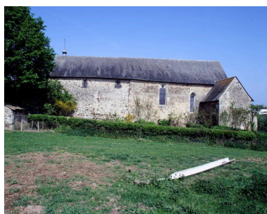
Elévation latérale sud : vue d'ensemble. Phot. François Lasa IVR52_20025300608XA
