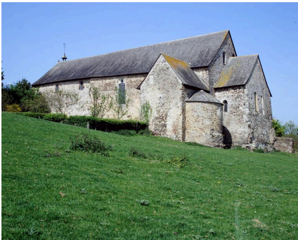
Elévation latérale sud : vue d'ensemble depuis le sud-est.
