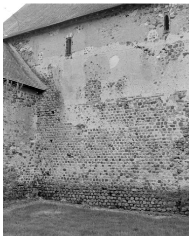
Elévation latérale nord, vue de détail : appareil. Phot. François Lasa IVR52_19995300095X
