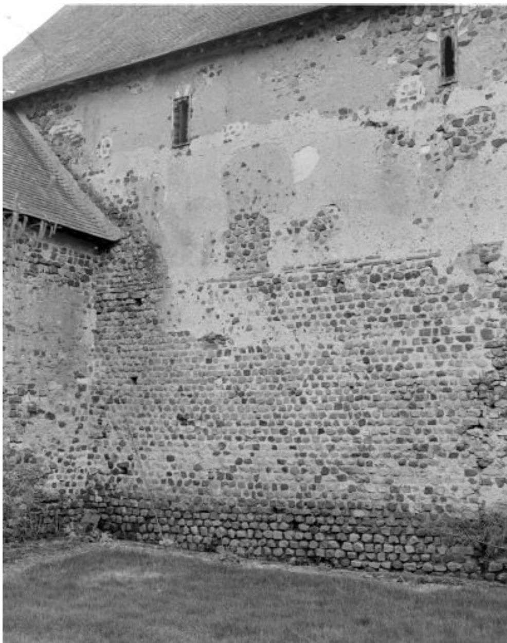
Elévation latérale nord, vue de détail : appareil.
