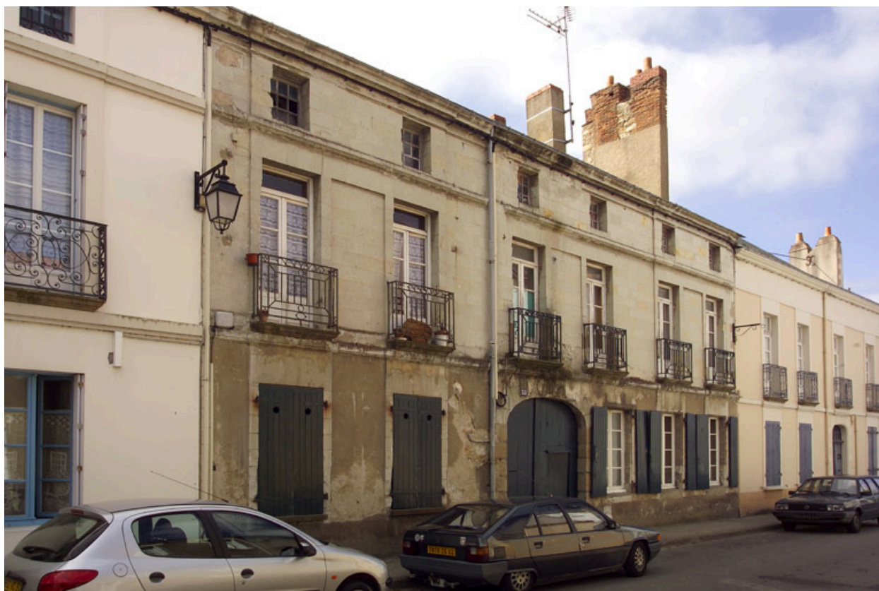
La façade sur la rue.
