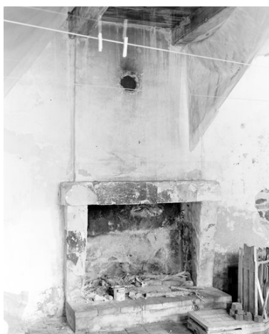
La cheminée du deuxième cellier (1998). Phot. François Lasa IVR52_19984400528X
