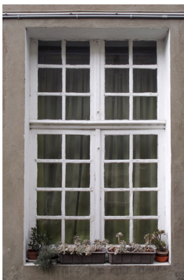
Le corps secondaire n° 5 quai Eole, cinquième travée, détail de la baie du rez-de-chaussée.
