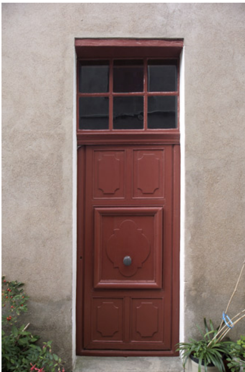
Le corps secondaire n° 5 quai Eole, quatrième travée à partir du corps principal, la porte d'accès à la cuisine.
