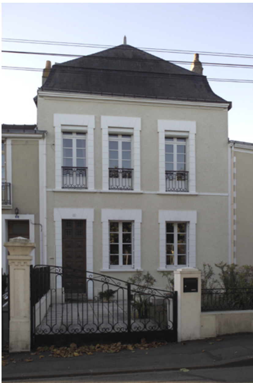
La maison n° 5 quai Eole vue depuis la rue.
