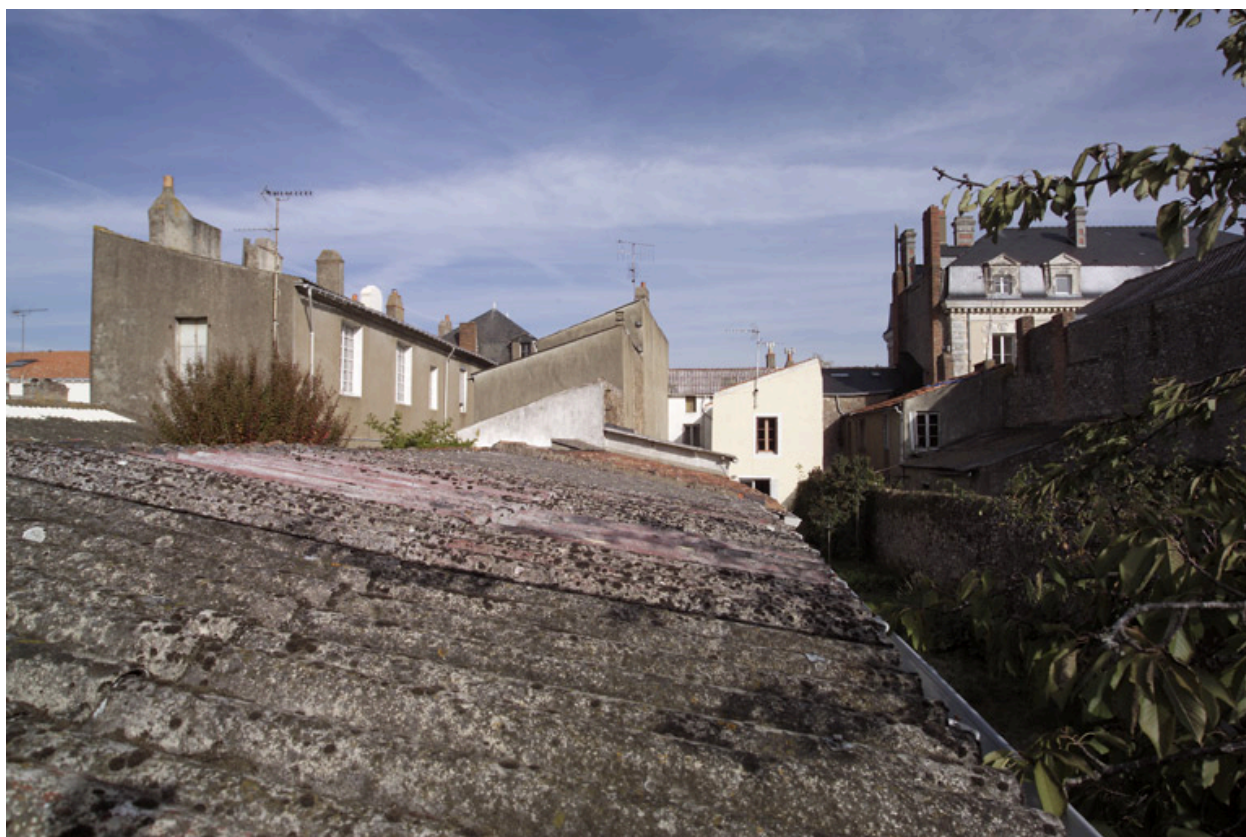
Les corps secondaires n° 5, n° 4, n° 3, n° 2 quai Eole depuis l'impasse des Caillebotes.
