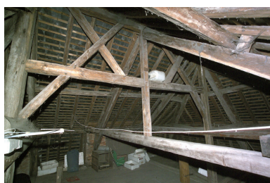
La charpente du corps principal n° 5 quai Eole.
