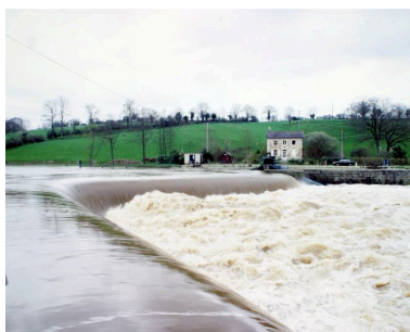
Vue d'ensemble du site depuis l'usine hydroélectrique sur la rive droite en aval : barrage, centrale hydroélectrique du pertuis, maison éclusière, transformateur. Phot. François Lasa IVR52_20025300493XA
