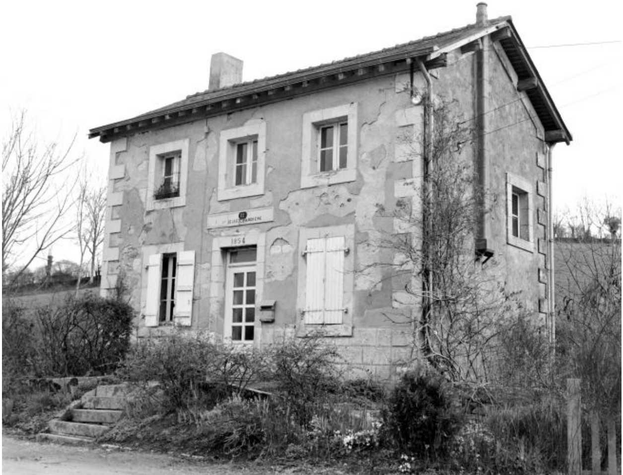
La maison éclusière.
