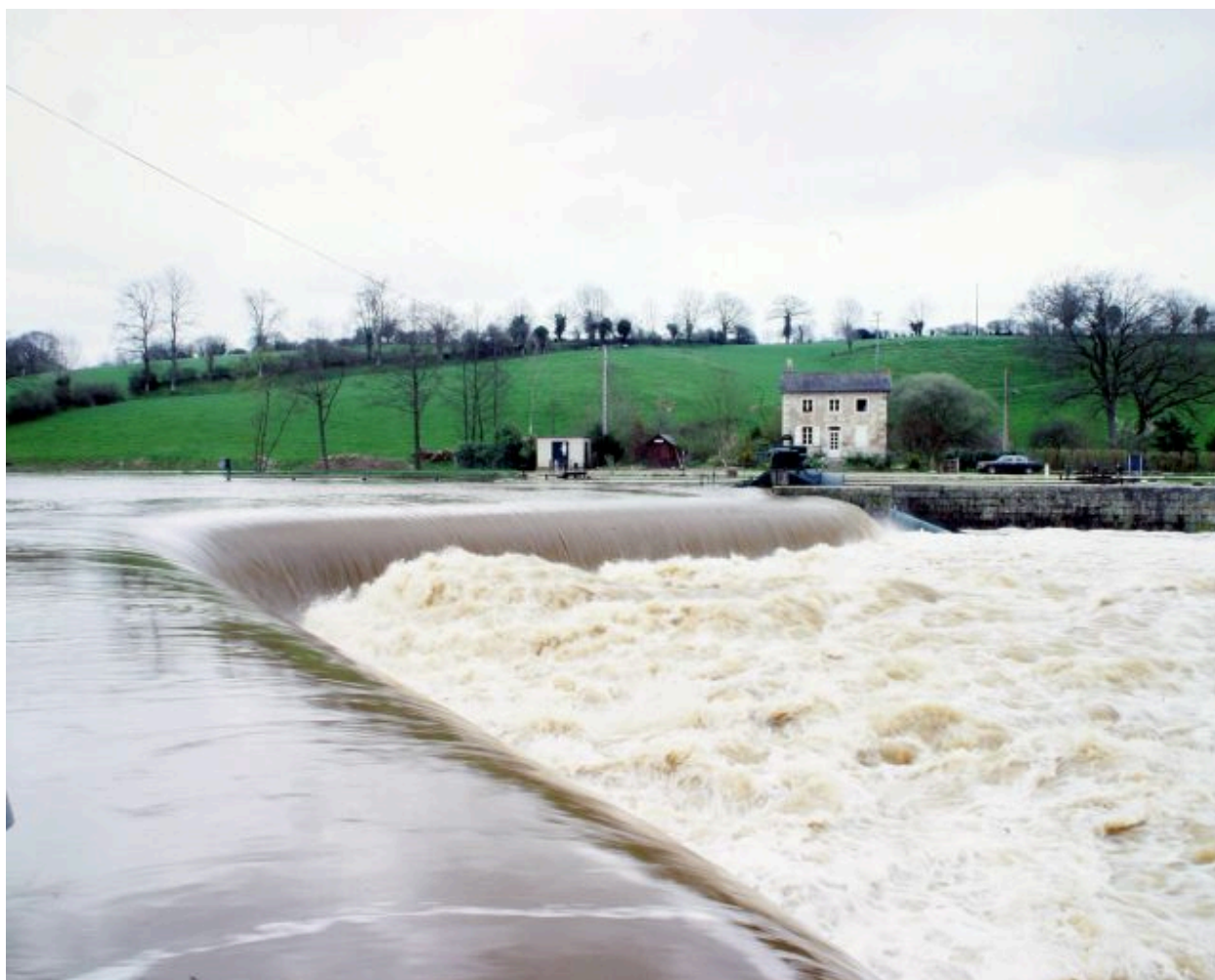
Vue d'ensemble du site depuis l'usine hydroélectrique sur la rive droite en aval : barrage, centrale hydroélectrique du pertuis, maison éclusière, transformateur.
