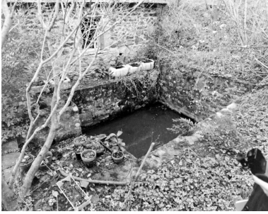
Bassin de récupération des eaux situé derrière la maison éclusière.
