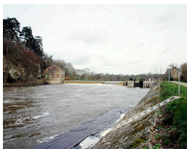
Vue d'ensemble du site depuis la rive gauche, en aval : centrale hydroélectrique, barrage, écluse, maison éclusière. Phot. François Lasa IVR52_20025300390XA
