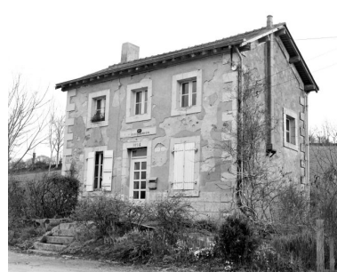
La maison éclusière. Phot. François Lasa IVR52_20025300388X
