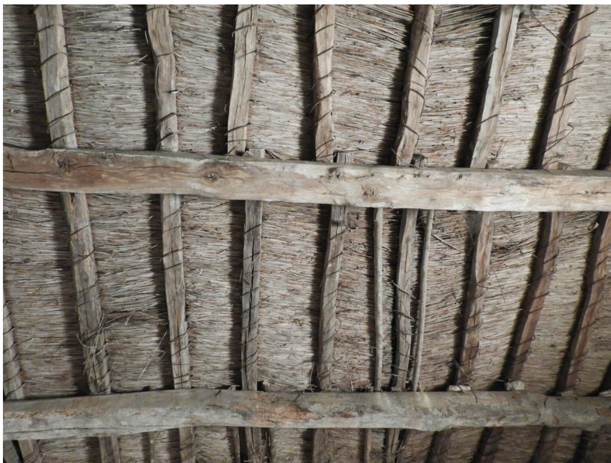
Le toit en roseau.
