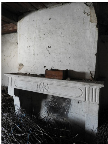
La cheminée à l'étage.
