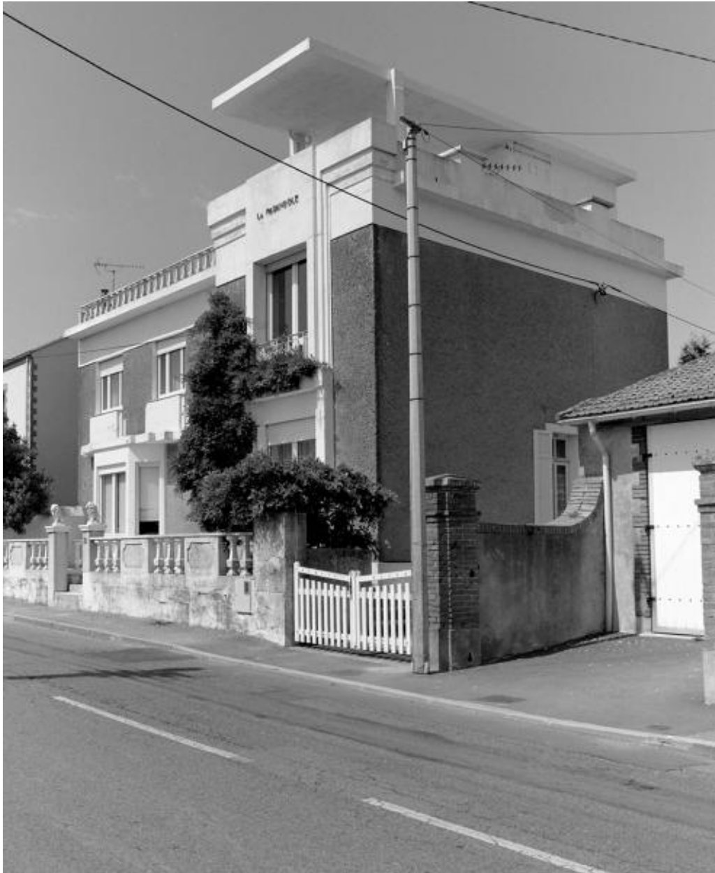
Elévation antérieure prise du sud-ouest.
