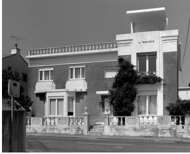
Elévation antérieure. Phot. Denis Pillet IVR52_19974402372X
