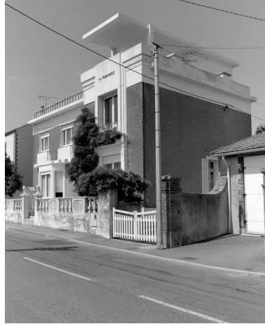
Elévation antérieure prise du sud-ouest. Phot. Denis Pillet IVR52_19974402371X
