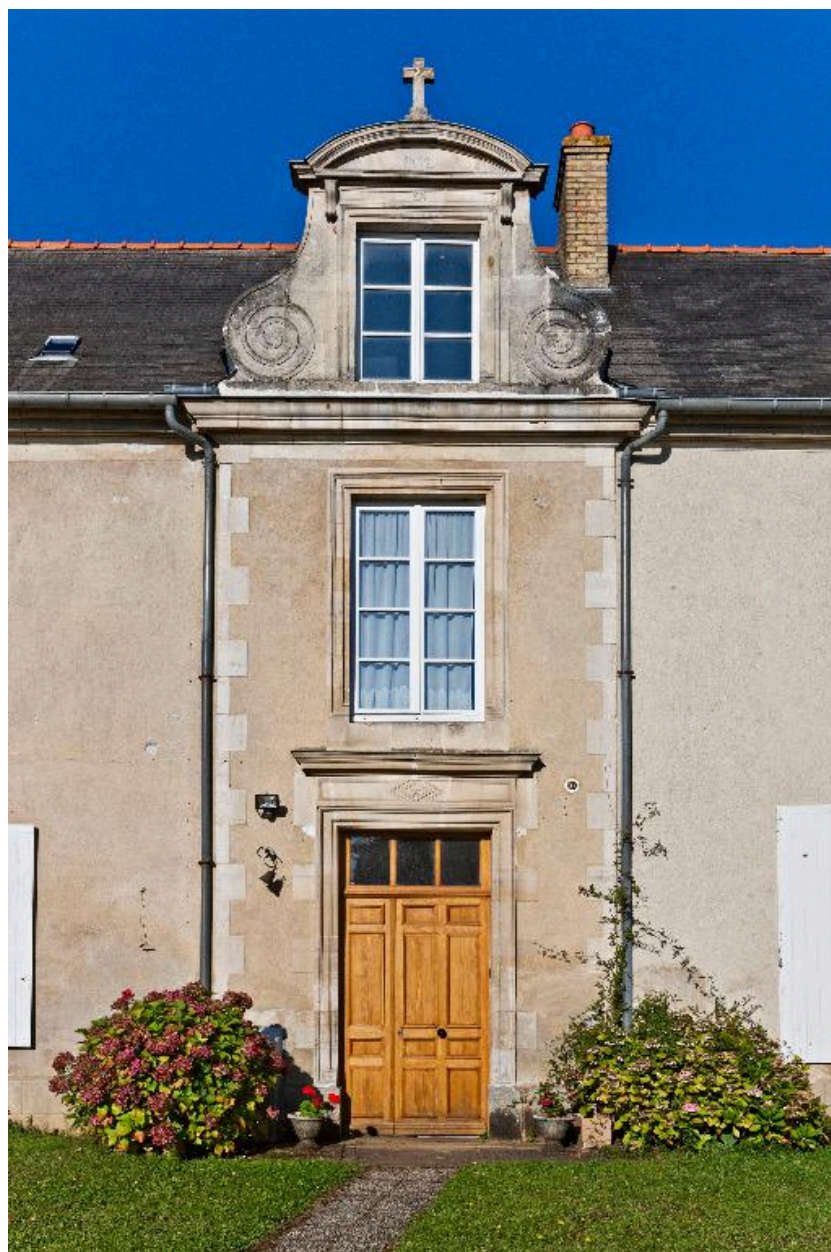
Détail de la travée centrale de l'élévation sur cour.
