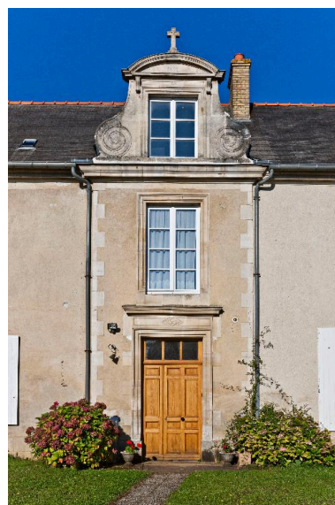
Détail de la travée centrale de l'élévation sur cour. Phot. Yves Guillotin IVR52_20147201977NUCA
