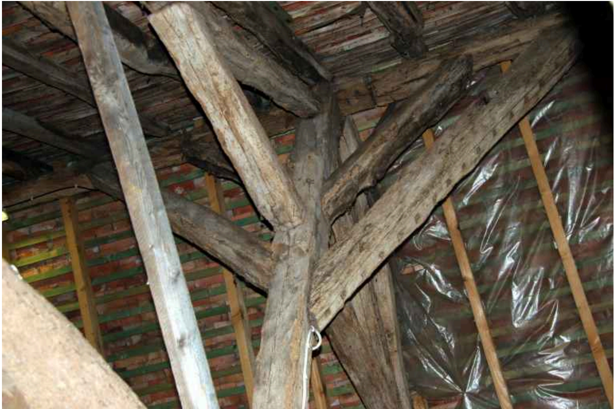
Maison n°1, dépendances : la charpente.
