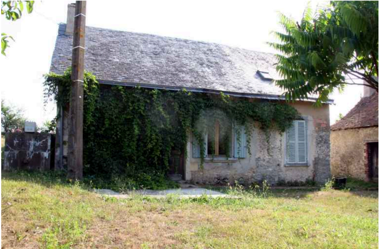
Maison n°1 : façade antérieure.
