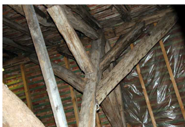
Maison n°1, dépendances : la charpente. Phot. Jean-Baptiste Darrasse IVR52_20067206490NUCA
