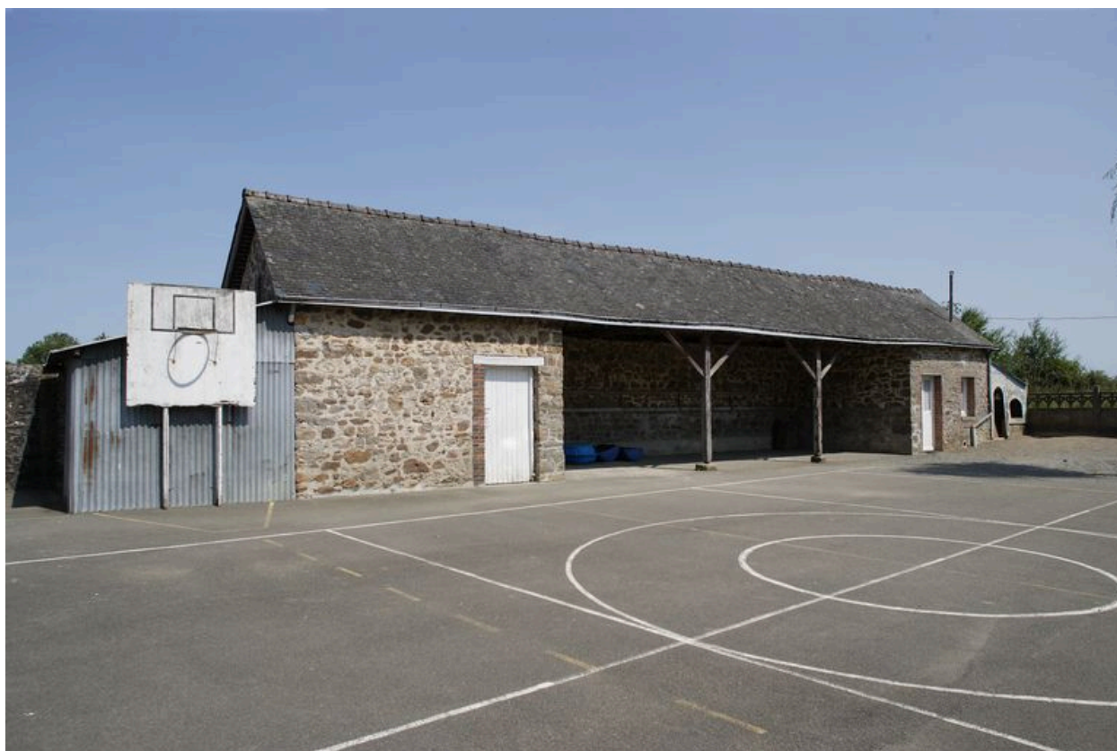
Le préau et la buanderie vus depuis la cour d'école à l'ouest.
