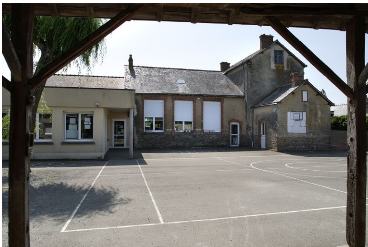
Vue d'ensemble depuis la cour d'école à l'est : les classes et le logement.
