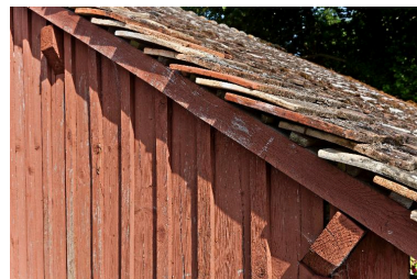
Détail de l'essentage de planches du pignon gauche. Phot. Yves Guillotin IVR52_20147201763NUCA
