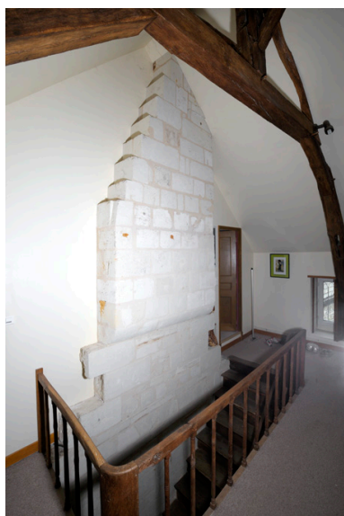
Vue du massif de maçonnerie abritant les conduits de cheminées, dans le comble. Phot. Bruno Rousseau, Phot. Youenn Communeau IVR52_20124901212NUCA
