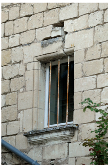
Pignon est. Baie (XVI e siècle), avec reprise de maçonnerie. Phot. Bruno Rousseau IVR52_20124901610NUCA
