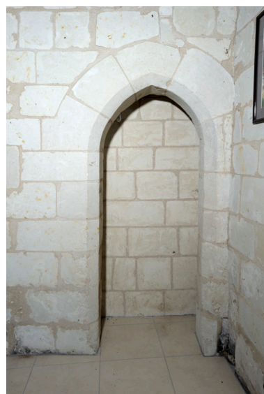
Rez-de-chaussée, salle est : ancien accès sur Loire par une porte (obturée) couverte en arc brisé, avec chanfrein et congés. Phot. Bruno Rousseau, Phot. Youenn Communeau IVR52_20124901210NUCA
