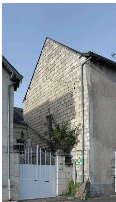
Pignon est, en petit appareil de tuffeau. Phot. Bruno Rousseau IVR52_20124901609NUCA
