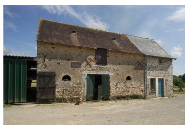
L'étable à chevaux. Phot. François Lasa IVR52_20055301989NUCA
