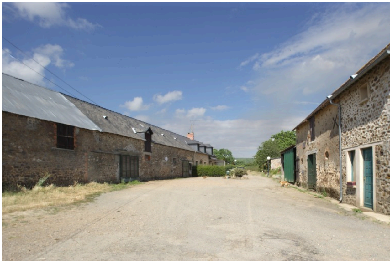
Vue d'ensemble depuis le chemin d'accès à l'ouest. A gauche, le logis-étable, à droite l'étable à chevaux.
