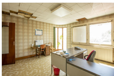
Bureaux, en partie ouest des bâtiments. Phot. Pierre-Bernard Fourny IVR52_20224400235NUCA
