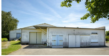
Bâti viticole, au nord du site. Phot. Pierre-Bernard Fourny IVR52_20224400228NUCA
