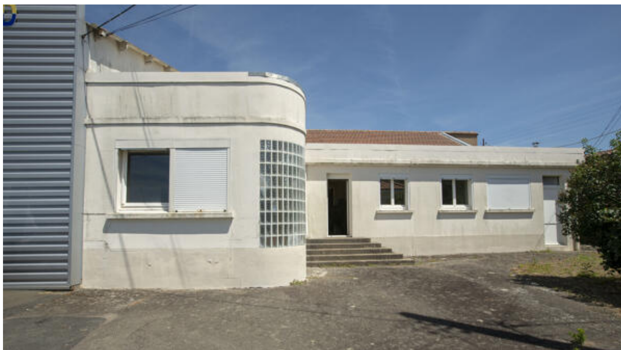
Vue générale du bâtiment de négoce sud.
