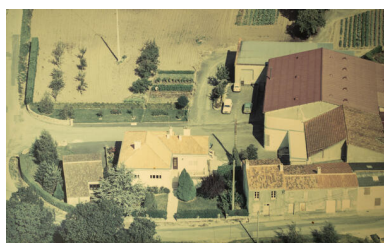
Vue aérienne de l'ensemble dédié au négoce (au second plan, toit rouge) et à la viticulture (au fond), dans les années 1970 (?). Repro. Pierre-Bernard Fourny IVR52_20224400233NUCA
