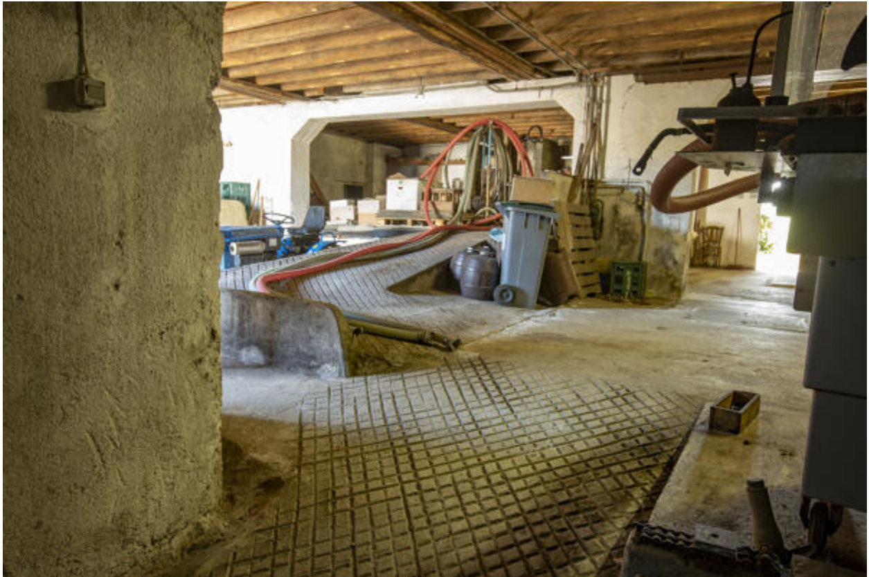
Vue des chais depuis l'est : quai et zone de stockage.
