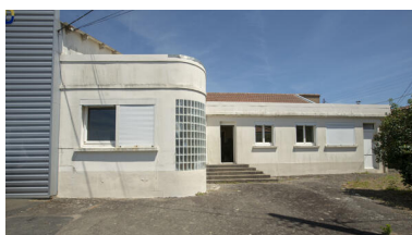
Vue générale du bâtiment de négoce sud. Phot. Pierre-Bernard Fourny IVR52_20224400229NUCA
