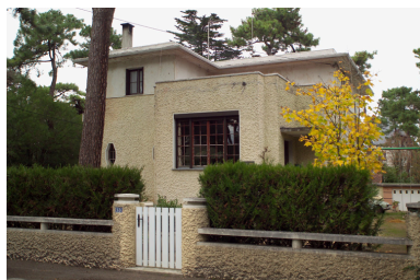
Vue d'ensemble de la villa Ker Christian. Phot. Denis Pillet IVR52_20044403276NUCA
