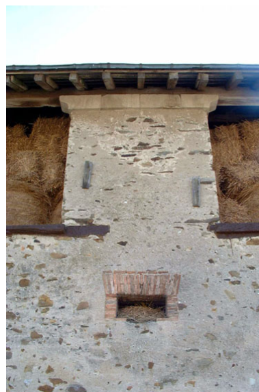
Etable : détail des ouvertures du fenil. Corniche en tuffeau supportant la sablière basse de la charpente. Jour en brique pour l'éclairage de l'étable. Phot. Gaël Carré, Phot. Thierry Pelloquet IVR52_20024902371NUCA
