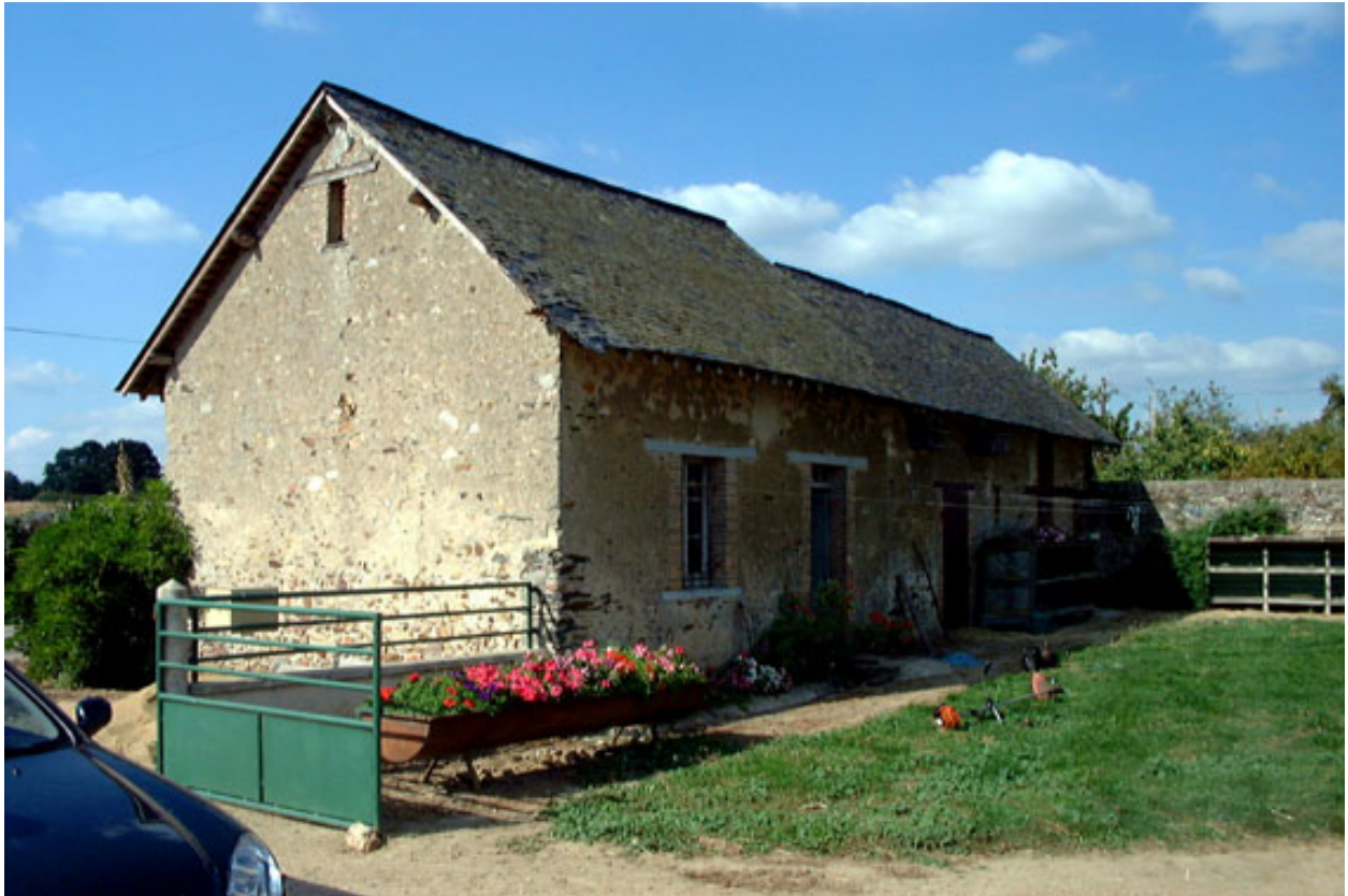
Bâtiment dans l'angle nord-ouest de la cour.
