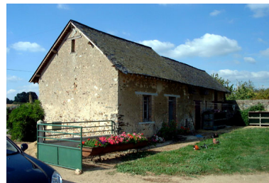
Bâtiment dans l'angle nord-ouest de la cour. Phot. Gaël Carré, Phot. Thierry Pelloquet IVR52_20024902368NUCA
