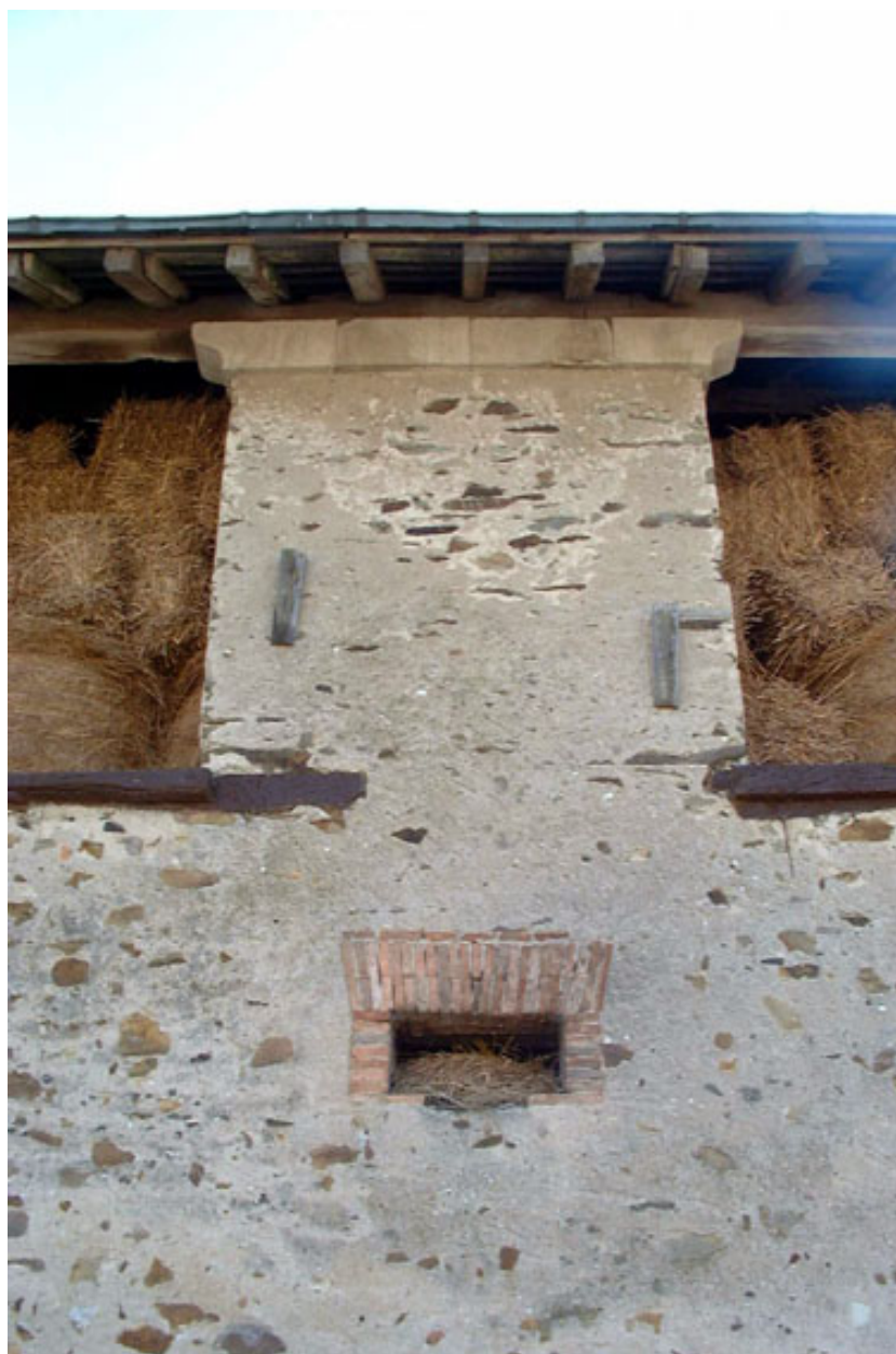
Etable : détail des ouvertures du fenil. Corniche en tuffeau supportant la sablière basse de la charpente. Jour en brique pour l'éclairage de l'étable.
