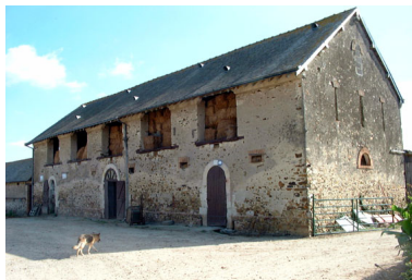
Etables avec fenil sur le côté sud de la cour, face au corps d'habitation. Phot. Gaël Carré, Phot. Thierry Pelloquet IVR52_20024902367NUCA
