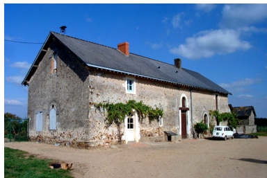
Corps d'habitation sur le côté nord de la cour. La moitié droite du bâtiment fait office de logis. Phot. Gaël Carré, Phot. Thierry Pelloquet IVR52_20024902366NUCA
