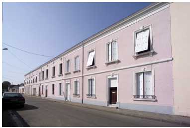
Vue d'ensemble vers la rue Pierre-Jubau. Phot. Denis Pillet IVR52_20034401160NUCA
