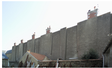
Vue d'ensemble des façades postérieure depuis la rue Pierre-Jubau. Phot. Denis Pillet IVR52_20034401161NUCA
