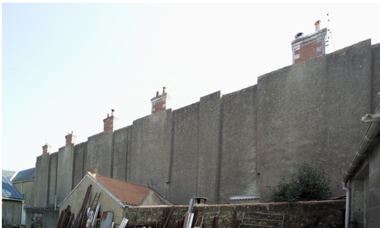
Vue d'ensemble des façades postérieure depuis la rue Pierre-Jubau.
