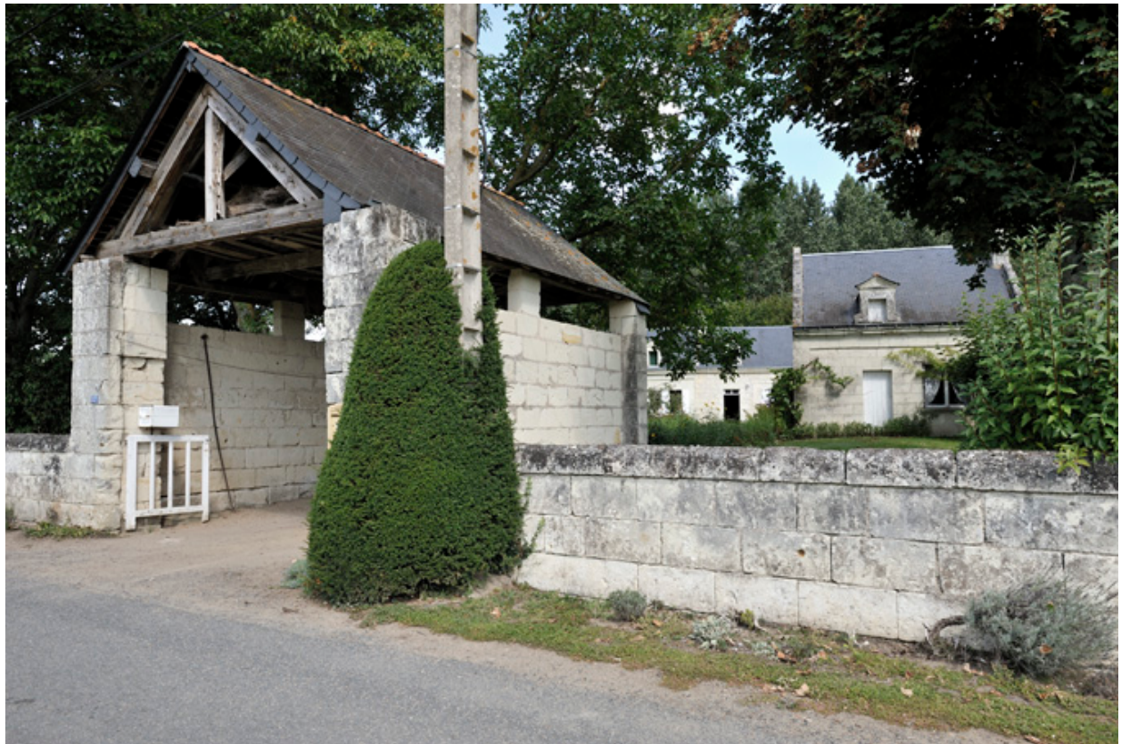
Vue d'ensemble depuis la rue.
