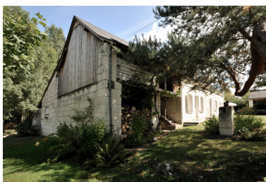
Vue de l'extrémité ouest de la rangée de maisons : remise et grange (XIXe siècle). Phot. Bruno Rousseau IVR52_20114902410NUCA
