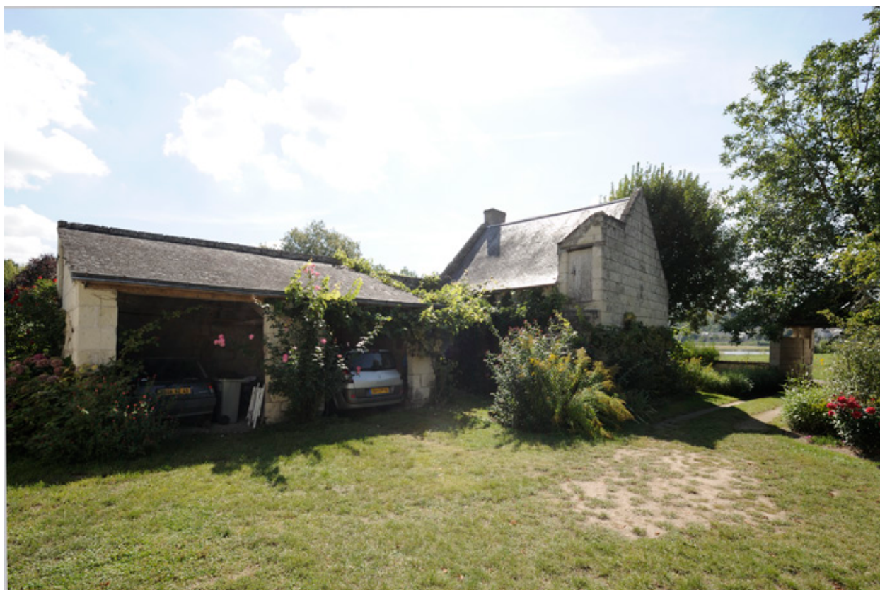
Façade postérieure de la maison du XVIIIe siècle (à droite) et communs du XIXe siècle (à gauche).
