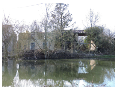
Les vestiges du logement ouest et de ses dépendances, vus depuis le nord. Phot. Yannis Suire IVR52_20228500145NUCA
