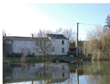
Le logement à l'est vu depuis le nord. Phot. Yannis Suire IVR52_20228500144NUCA
