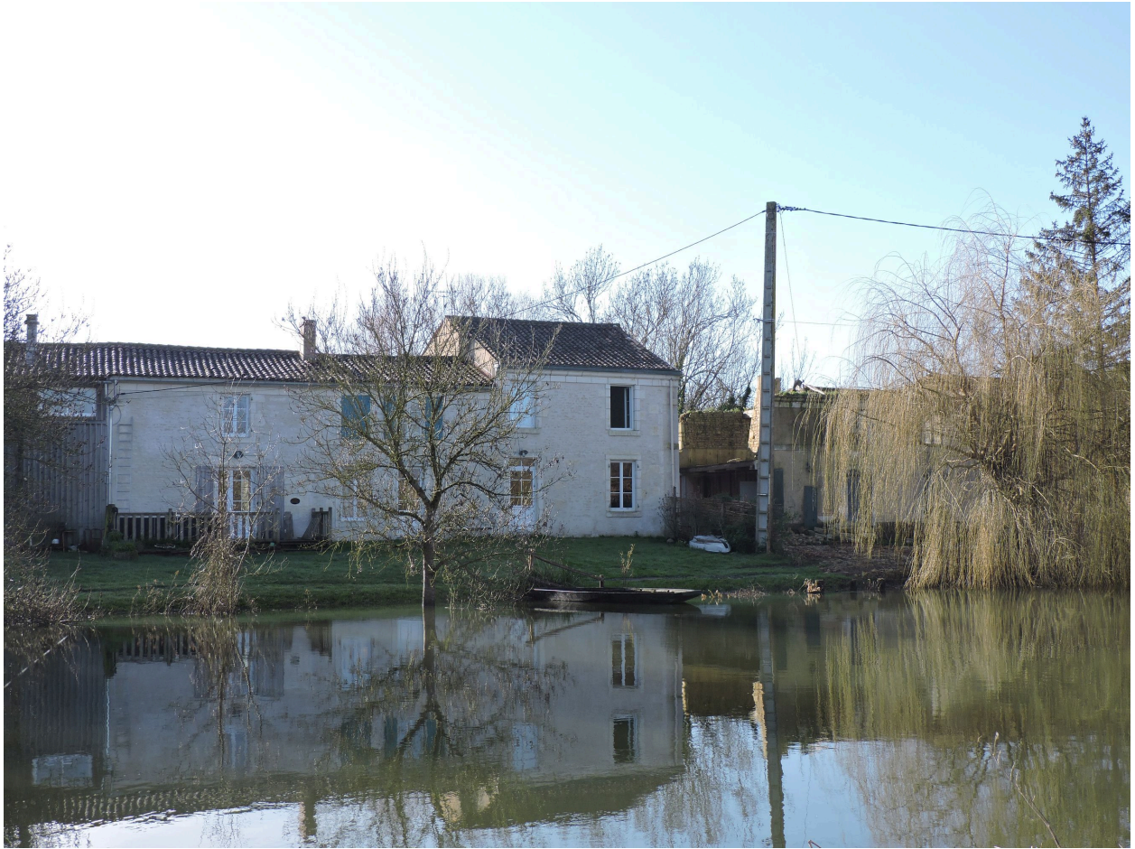
Le logement à l'est vu depuis le nord.
