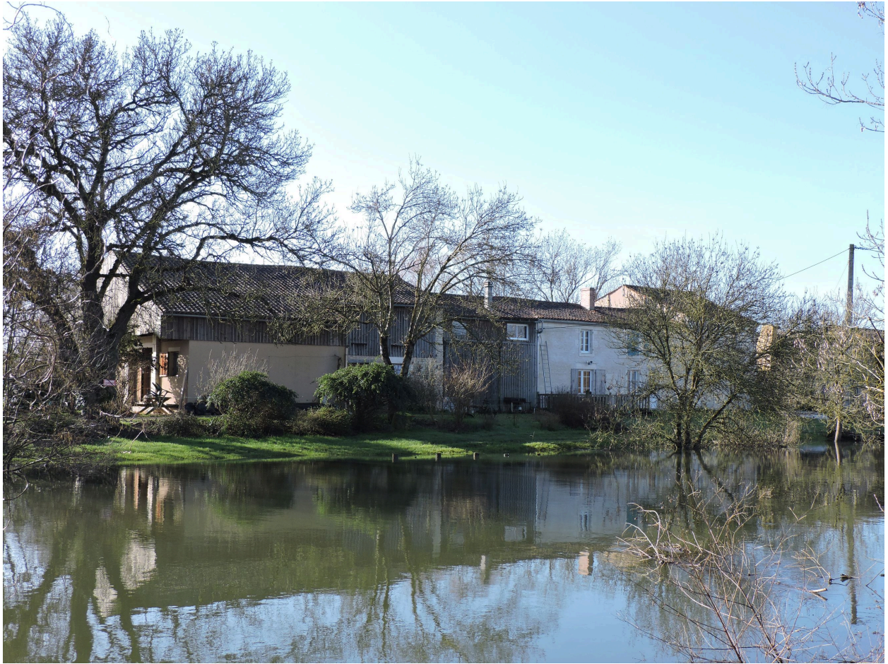
L'ancienne ferme vue depuis le nord-ouest.
