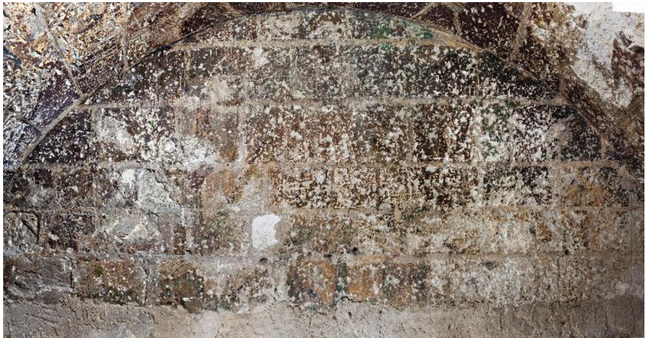
Enfeu, mur du fond. Résurrection des morts, vue d'ensemble.
