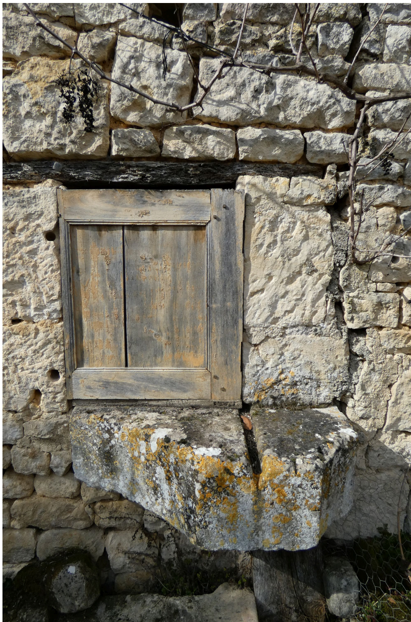
Pierre d'évier sur le fournil au sud des logements.
