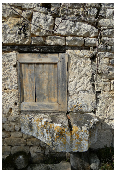
Pierre d'évier sur le fournil au sud des logements. Phot. Yannis Suire IVR52_20238500782NUCA
