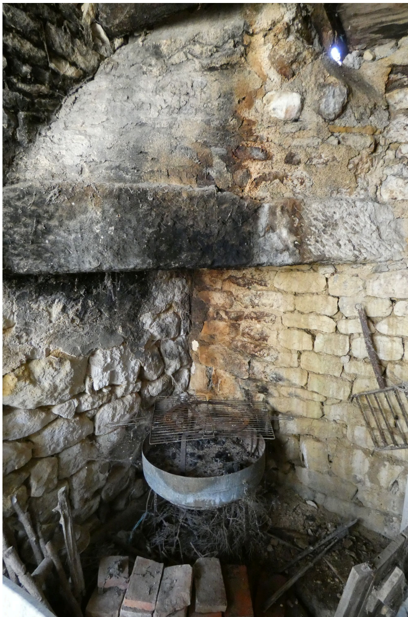
Cheminée d'angle dans le fournil.
