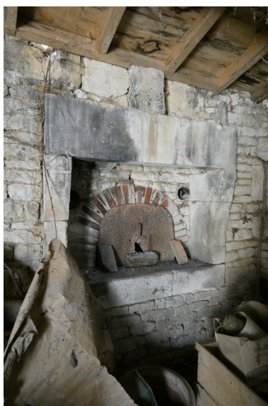
Le four. Phot. Yannis Suire IVR52_20238500784NUCA
