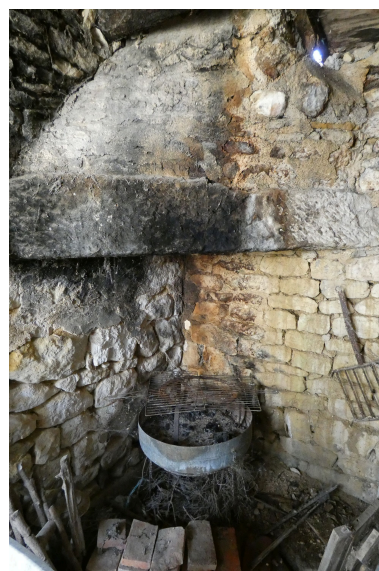
Cheminée d'angle dans le fournil. Phot. Yannis Suire IVR52_20238500786NUCA
