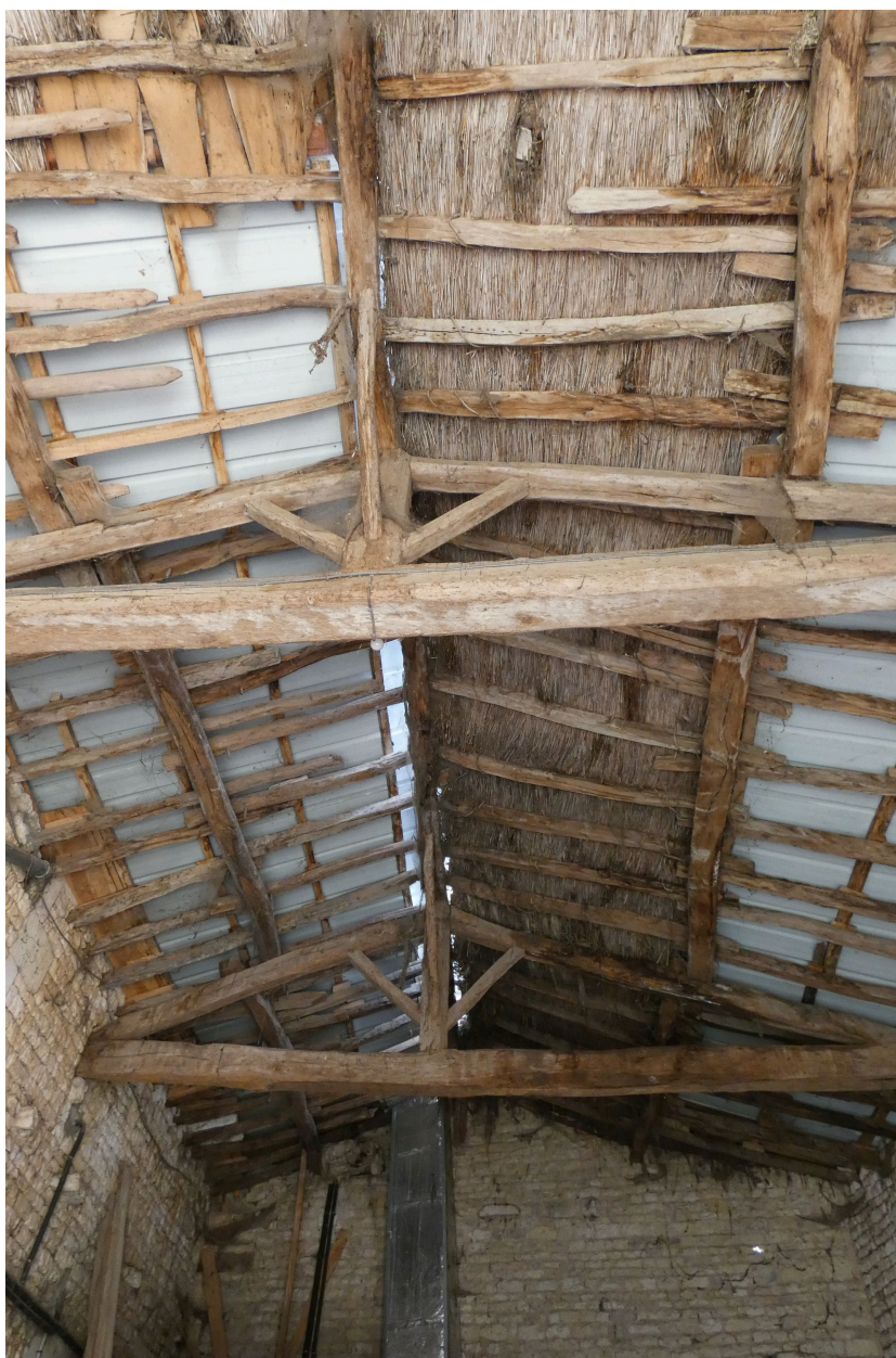
La charpente de la grange-étable.
