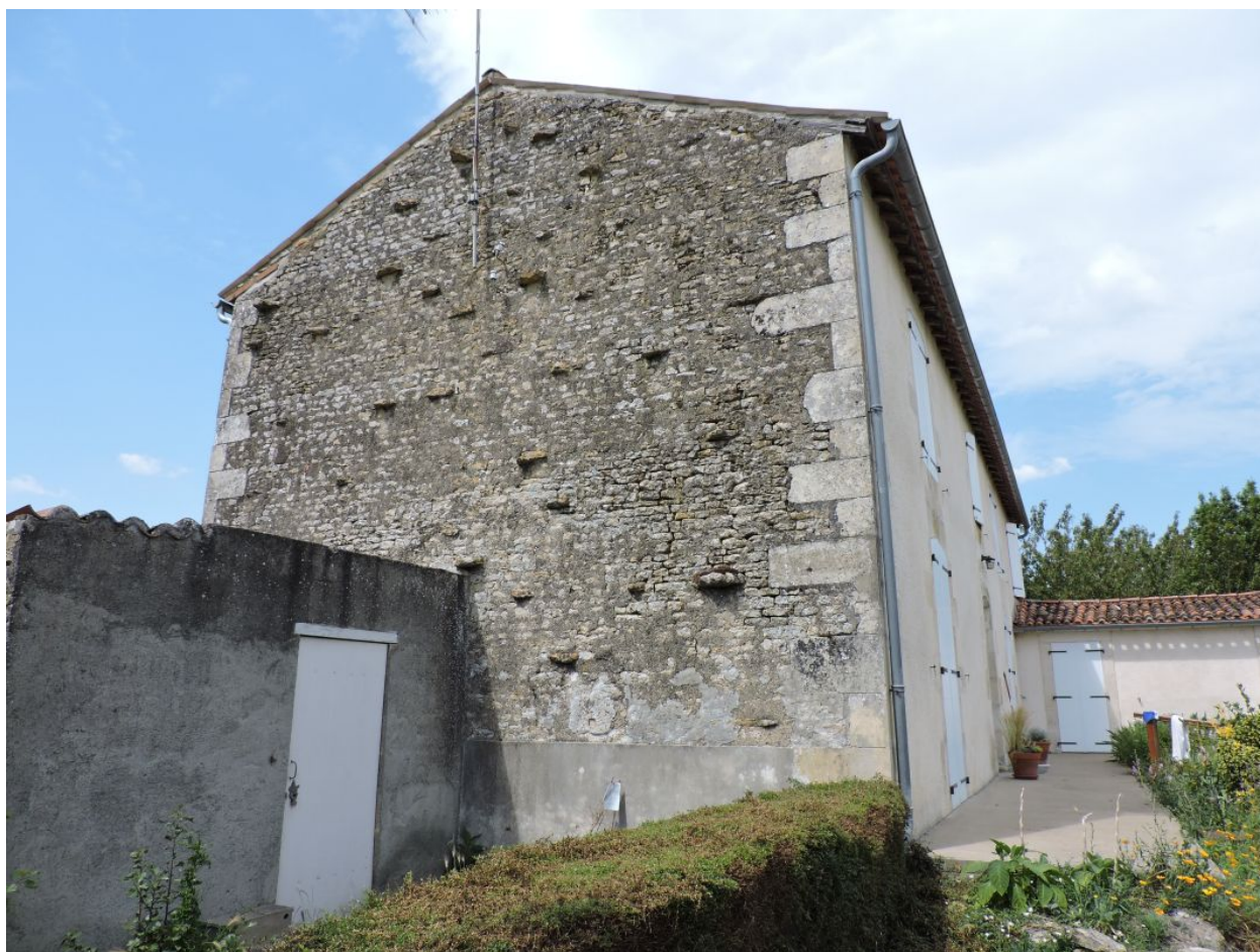
Le mur pignon sud-ouest du logis.
