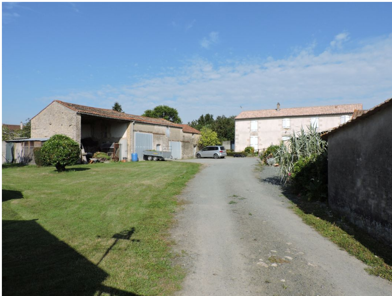
La propriété vue depuis l'est.
