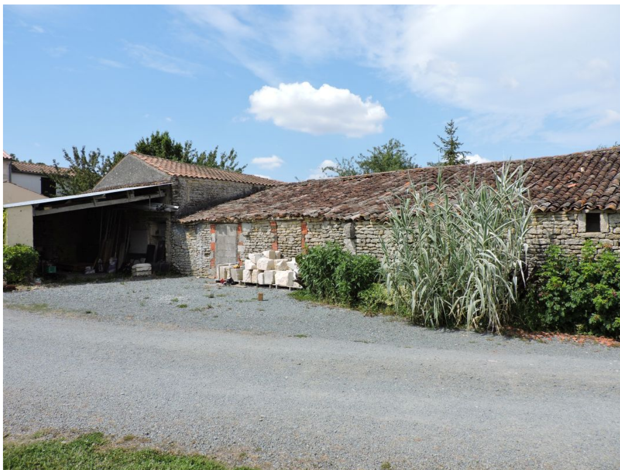
Anciennes dépendances au nord-est de la cour, vues depuis le sud.
