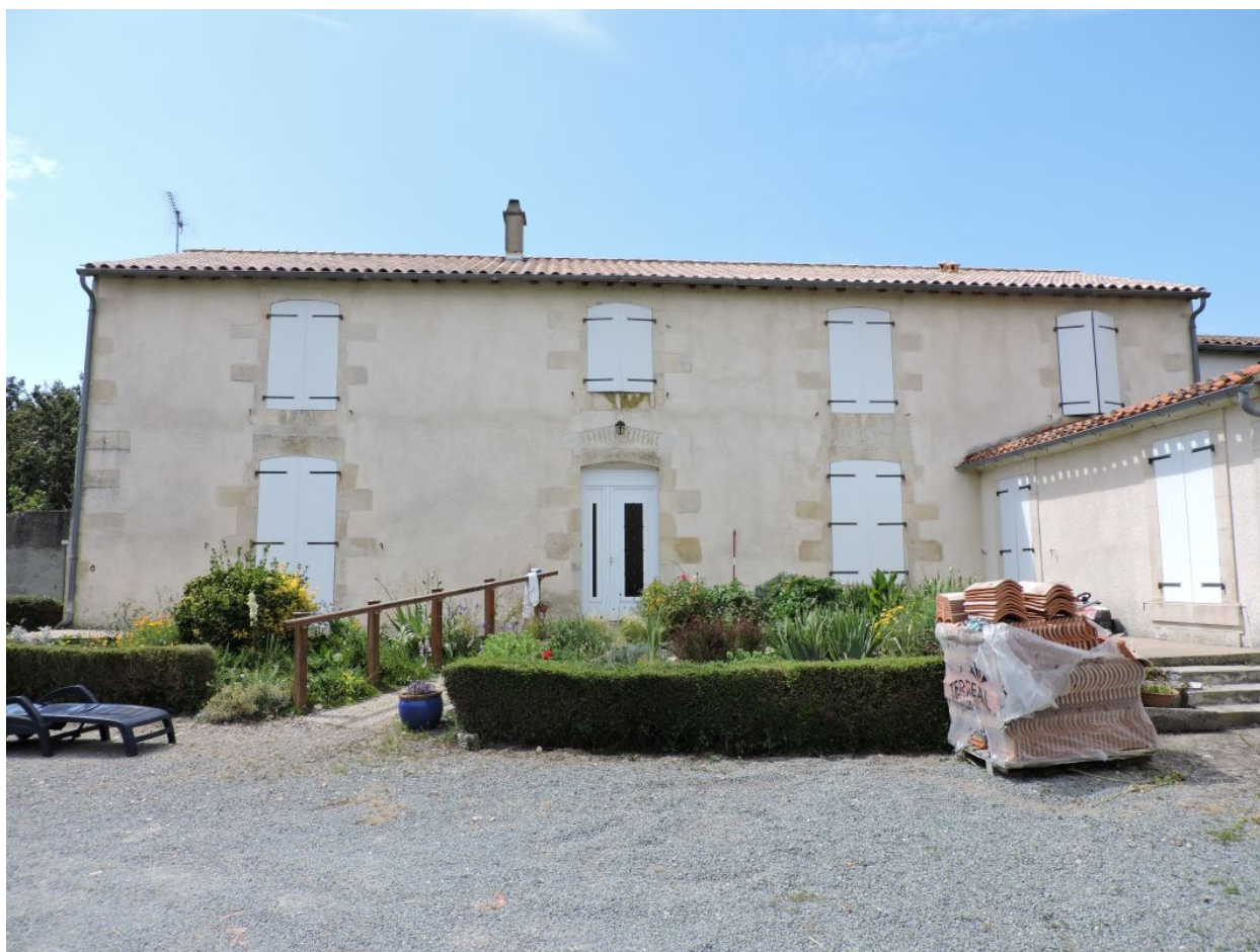
Le logis vu depuis le sud-est.
