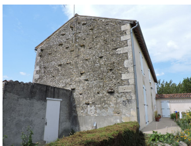
Le mur pignon sud-ouest du logis. Phot. Yannis Suire IVR52_20198502426NUCA
