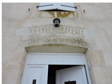
L'arc de décharge au-dessus de la porte. Phot. Yannis Suire IVR52_20198502429NUCA
