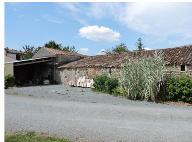
Anciennes dépendances au nord- est de la cour, vues depuis le sud. Phot. Yannis Suire IVR52_20198502434NUCA
