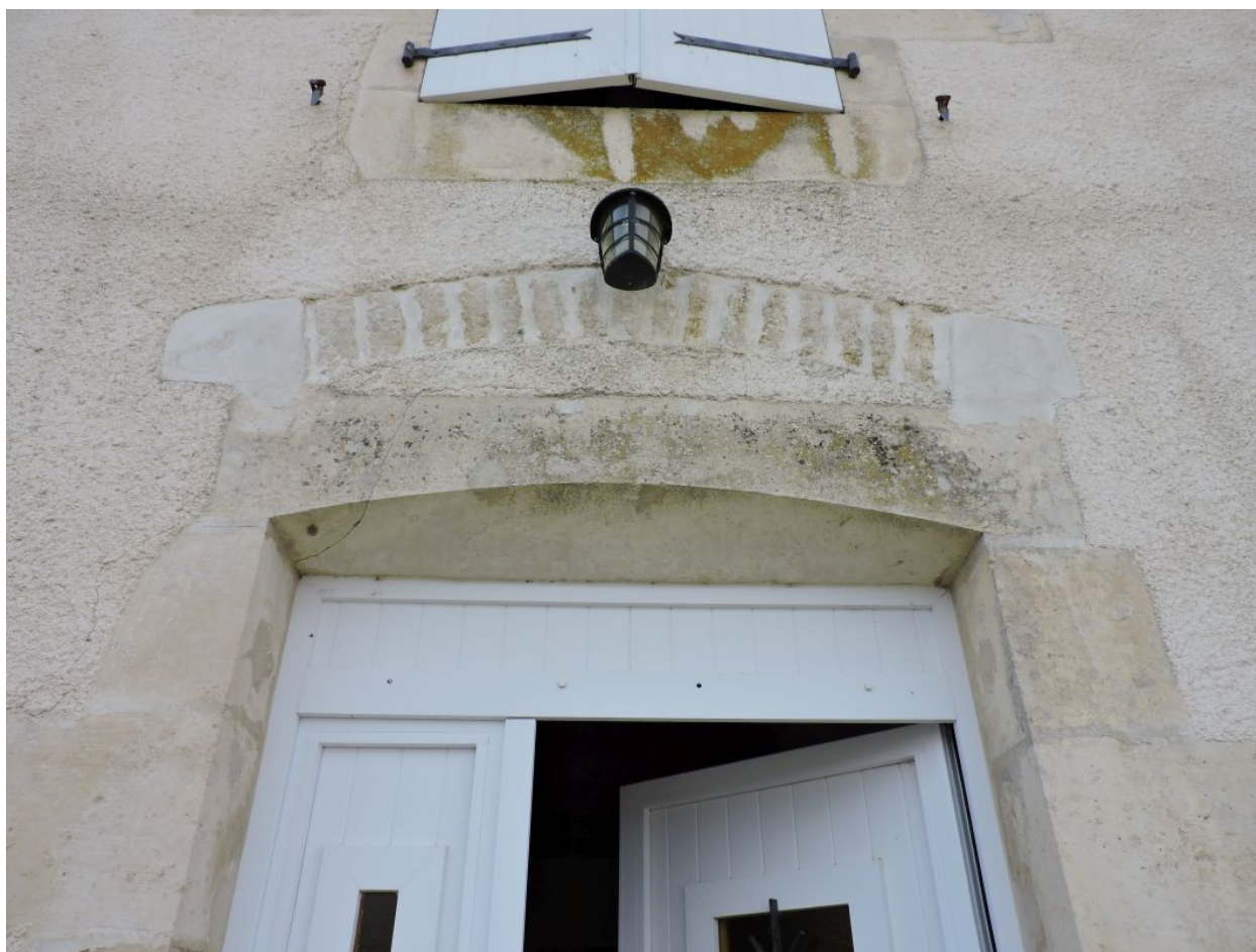
L'arc de décharge au-dessus de la porte.
