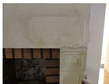
Détail de la cheminée : décor mouluré. Phot. Yannis Suire IVR52_20198502433NUCA
