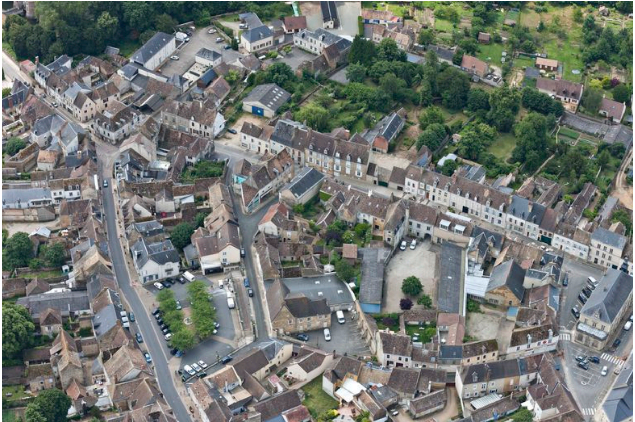
Vue aérienne depuis le nord-est.
