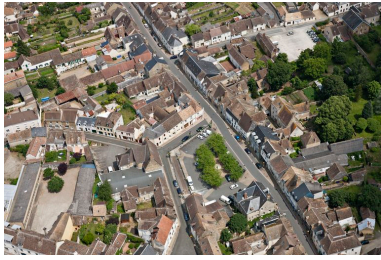
Vue aérienne. Phot. Yves Guillotin IVR52_20137201184NUCA
