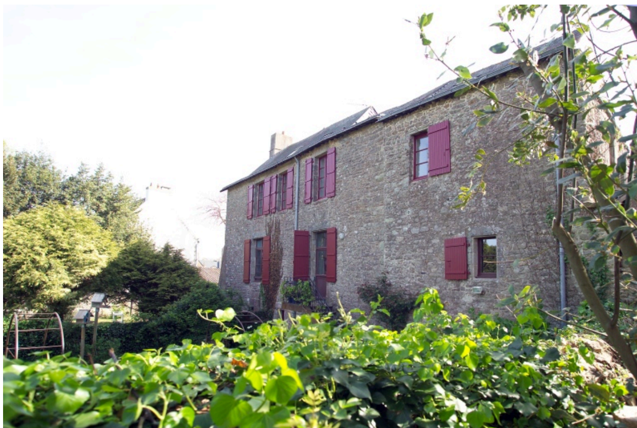
Vue de la façade arrière.
