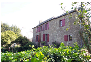
Vue de la façade arrière. Phot. Denis Pillet IVR52_20074400713NUCA
