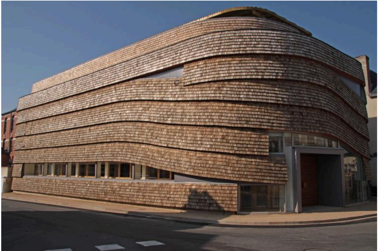
Vue prise depuis la rue.
