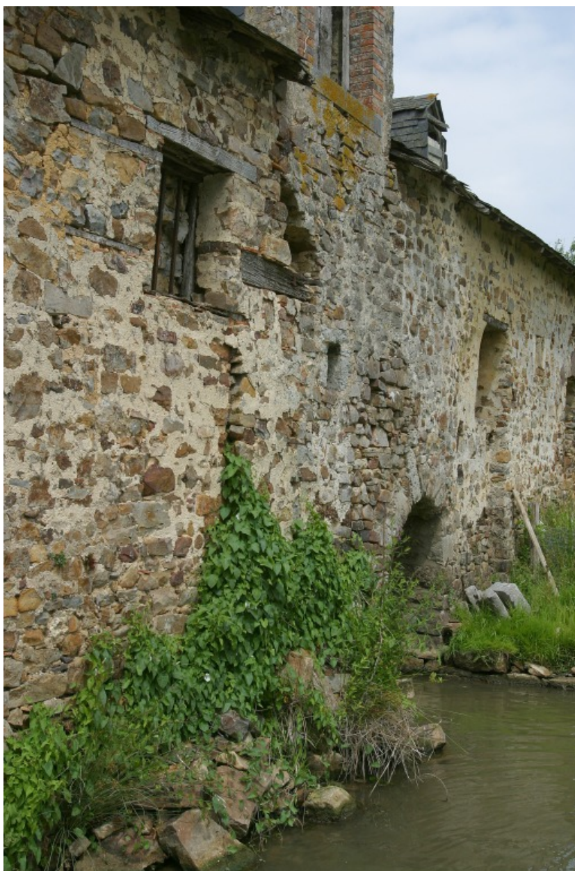
Détail de l'élévation sud : la partie centrale avec le coursier est.
