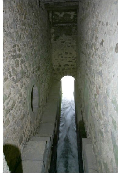
Le coursier ouest vu depuis le nord.
