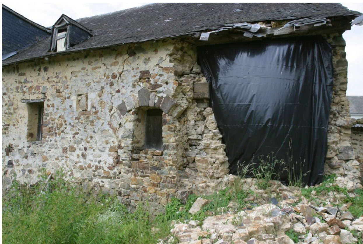
Détail de l'élévation sud du moulin : l'extrémité est.
