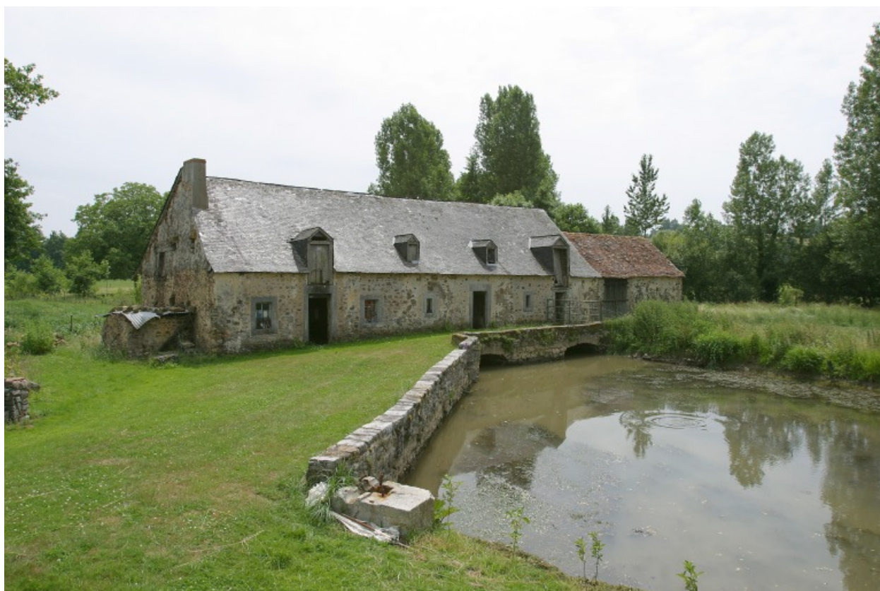
L'élévation nord du moulin et le canal d'alimentation, vus depuis le nord-est..
