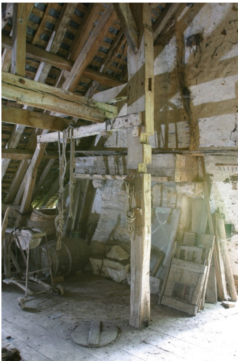
La cheminée située contre le mur est du comble.
