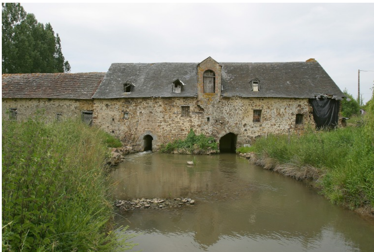
L'élévation sud du moulin et le canal de fuite, vus depuis le sud.
