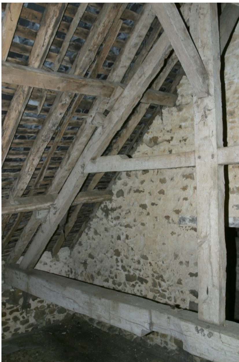
Ferme située à l'extrémité ouest du comble.
