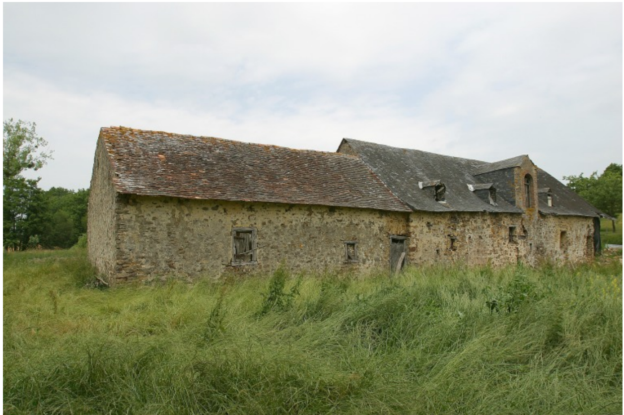
L'élévation sud de la remise et du moulin, vue depuis sud-ouest.
