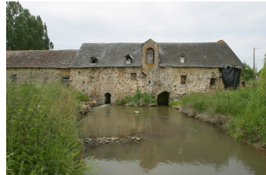
L'élévation sud du moulin et le canal de fuite, vus depuis le sud. Phot. François Lasa IVR52_20035302099NUCA
