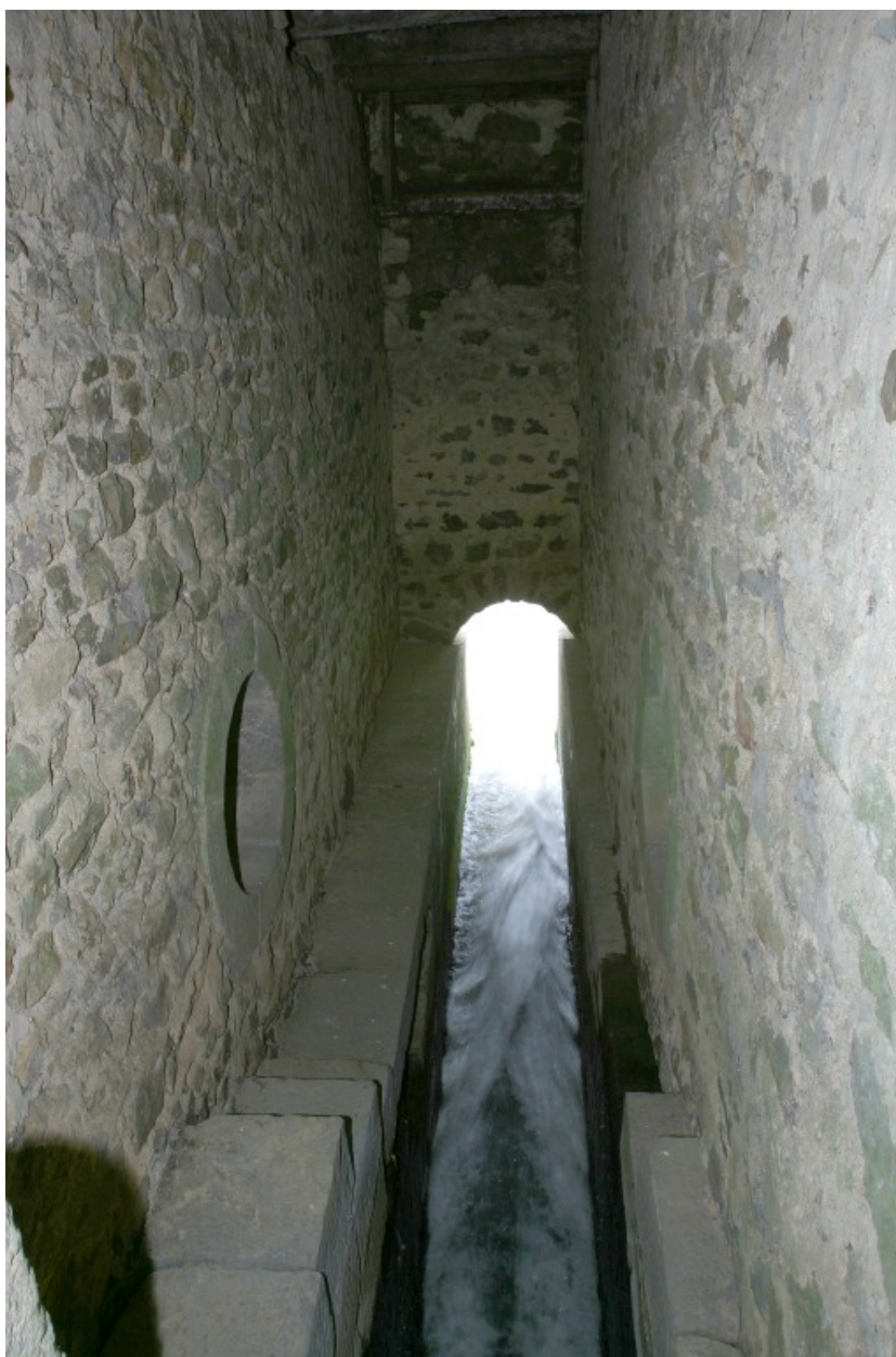
Le coursier ouest vu depuis le nord.
