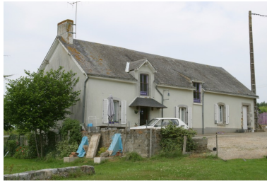
La maison, vue depuis le sud. Phot. François Lasa IVR52_20035302110NUCA
