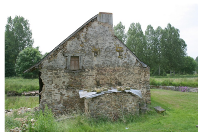
L'élévation latérale est du moulin. Phot. François Lasa IVR52_20035302096NUCA
