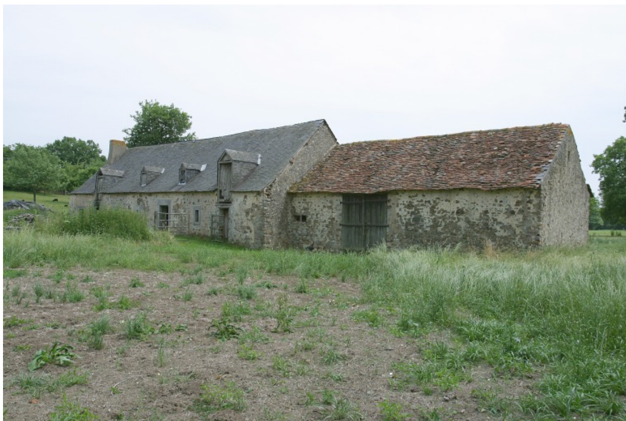
L'élévation nord du moulin et de la remise vue depuis le nord-ouest.
