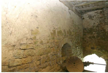
Le coursier est vu depuis le nord.
