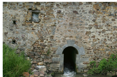
Détail de l'élévation sud : l'actuelle et l'ancienne sorties du coursier ouest. Phot. François Lasa IVR52_20035302100NUCA
