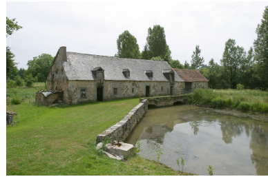
L'élévation nord du moulin et le canal d'alimentation, vus depuis le nord-est.. Phot. François Lasa IVR52_20035302095NUCA
