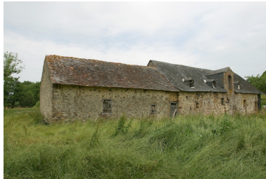
L'élévation sud de la remise et du moulin, vue depuis sud-ouest. Phot. François Lasa IVR52_20035302102NUCA
