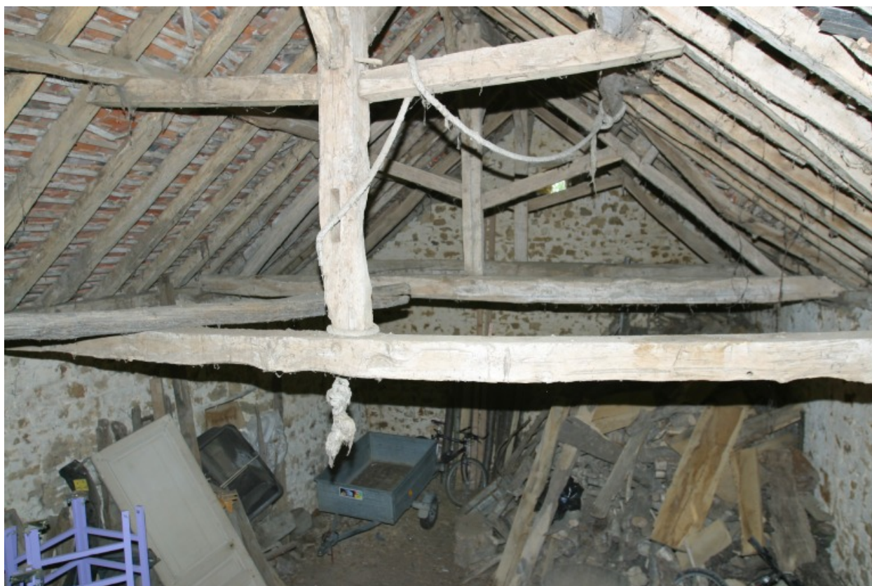
La charpente de la remise.
