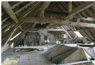
Le comble du moulin vu depuis l'ouest.
