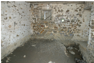
La pièce ouest du moulin, située entre le coursier ouest et le bâtiment de la remise : sur le mur sud, la trace de l'ancien coursier ouest.
