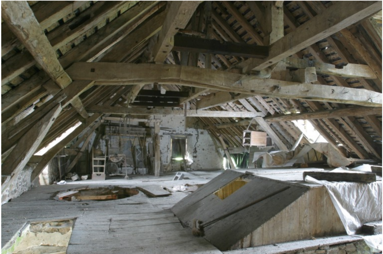
Le comble du moulin vu depuis l'ouest.
