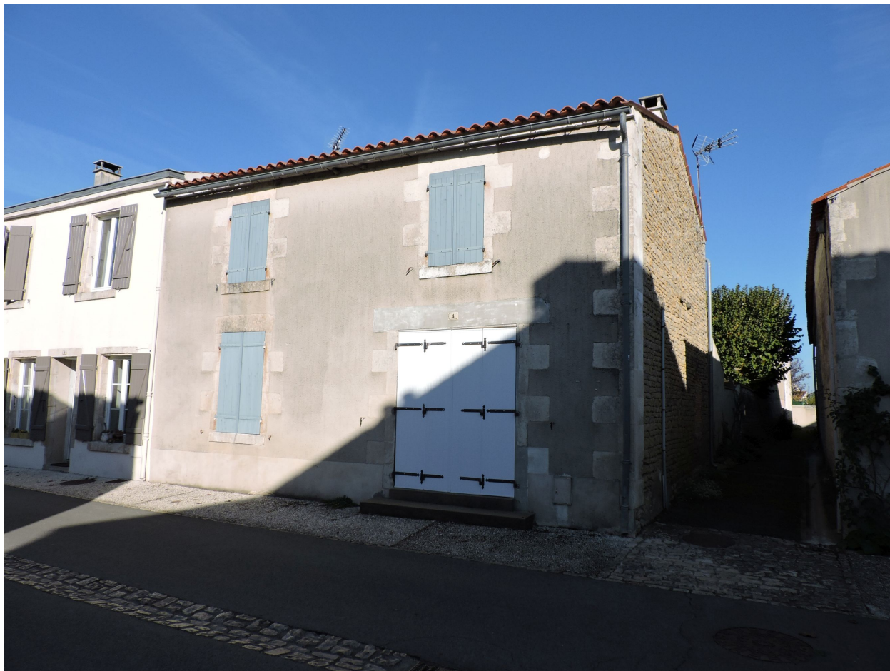
Vue depuis le sud-est.
