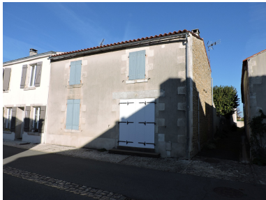
Vue depuis le sud-est. Phot. Yannis Suire IVR52_20218500218NUCA
