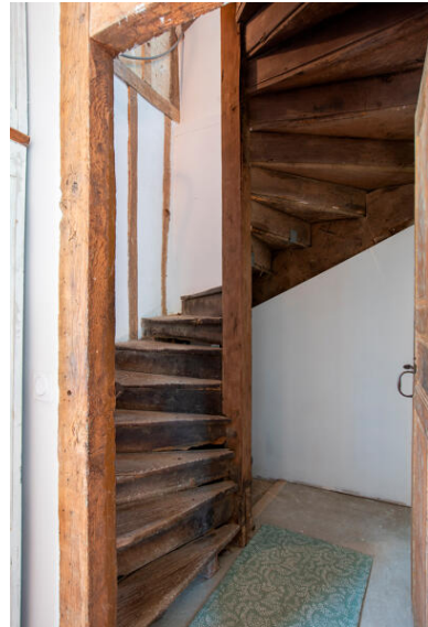
L'escalier du logis. Phot. Pierre-Bernard Fourny IVR52_20235300331NUCA
