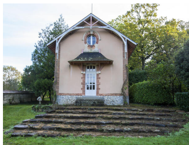
Le logement du jardinier. Phot. Pierre-Bernard Fourny IVR52_20235301744NUCA
