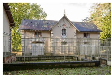
La seconde écurie-remise. Phot. Pierre-Bernard Fourny IVR52_20235301727NUCA
