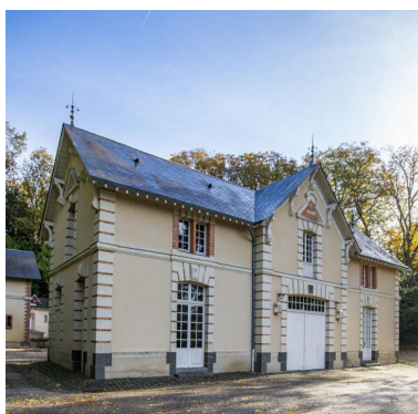
La seconde écurie-remise. Phot. Pierre-Bernard Fourny IVR52_20235301723NUCA
