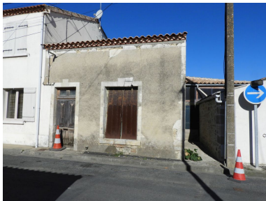
La maison vue depuis le sud-est. A droite, la remise dans l'angle de laquelle (derrière le poteau) est remployée une pierre inscrite. Phot. Yannis Suire IVR52_20198500086NUCA
