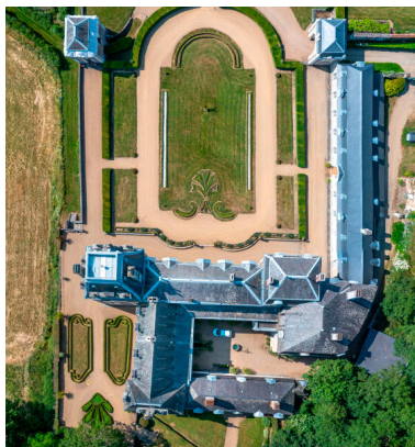
Une vue aérienne des toits du château et du parterre. Phot. Pierre-Bernard Fourny IVR52_20235300624NUCA
