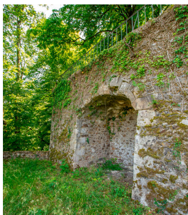
Le soubassement du belvédère. Phot. Pierre-Bernard Fourny IVR52_20235300780NUCA
