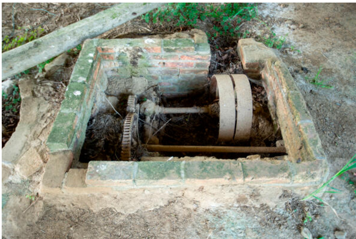
Le manège du puits artésien, détail.
