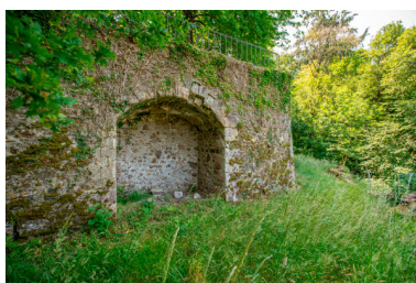
Le soubassement du belvédère. Phot. Pierre-Bernard Fourny IVR52_20235300781NUCA
