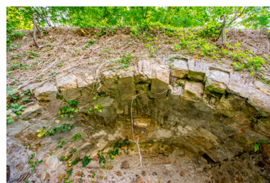
Un détail d'une alcôve sous le belvédère. Phot. Pierre-Bernard Fourny IVR52_20235300782NUCA
