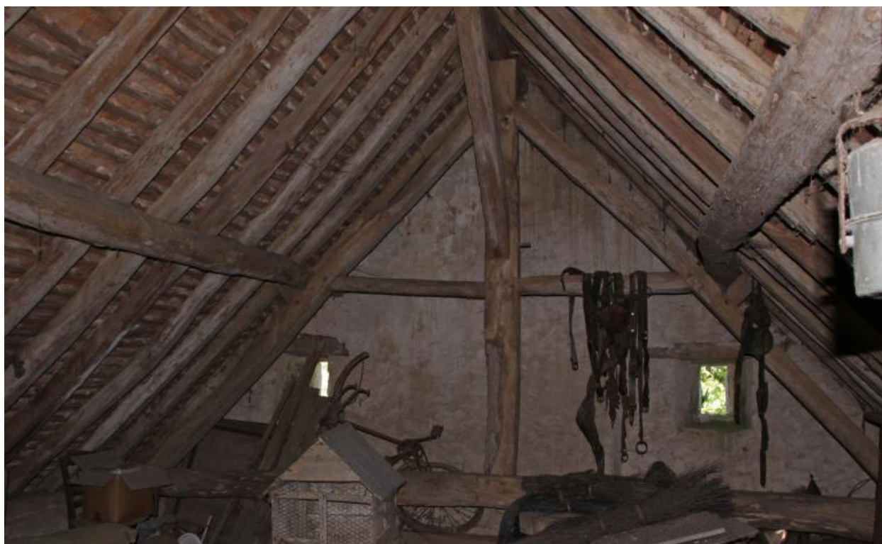
Maison 1 : charpente côté pignon ouest.
