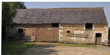
Grange-étable de la maison 2 : façade sur cour. Phot. Jean-Baptiste Darrasse IVR52_20107200975NUCA
