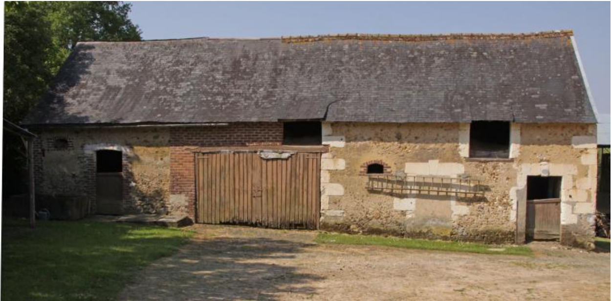
Grange-étable de la maison 2 : façade sur cour.
