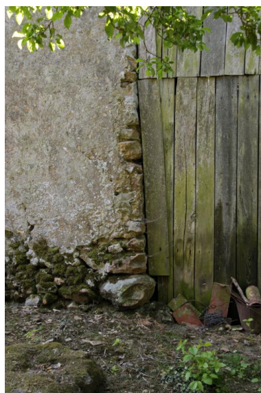
Maison 1 : détail chaînage d'angle façade nord, côté ouest. Phot. Jean-Baptiste Darrasse IVR52_20107200979NUCA
