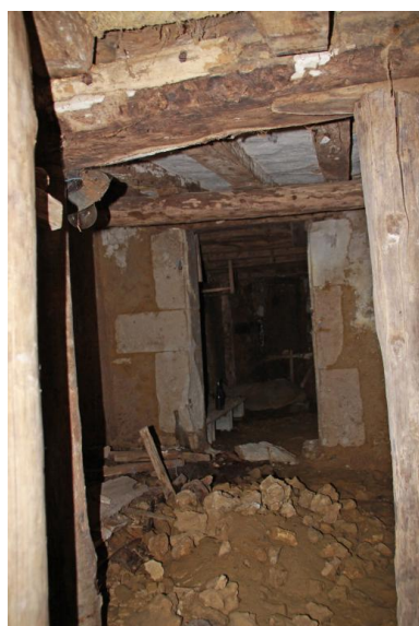
Maison 1 : cave (entrée par l'ouest) Phot. Jean-Baptiste Darrasse IVR52_20107200980NUCA
