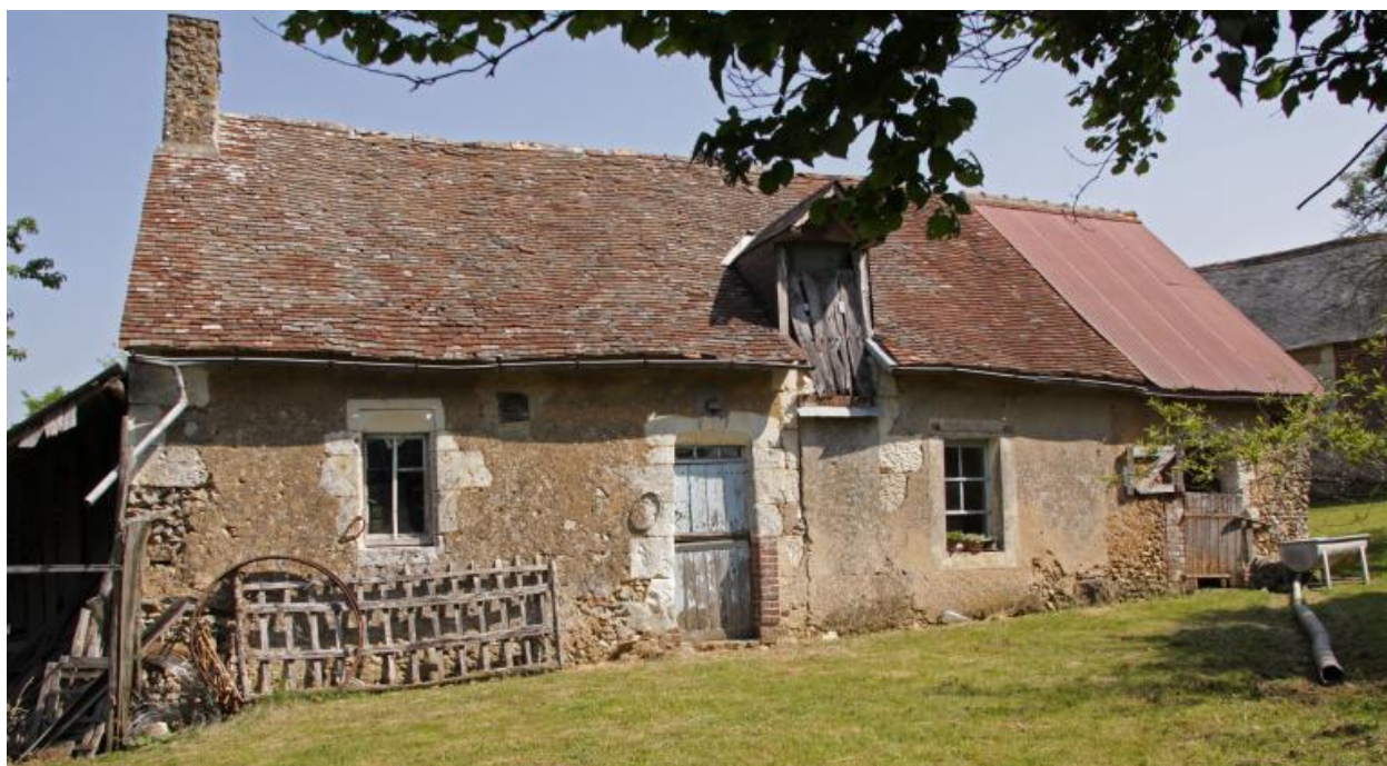
Maison 1 : façade antérieure (sud).
