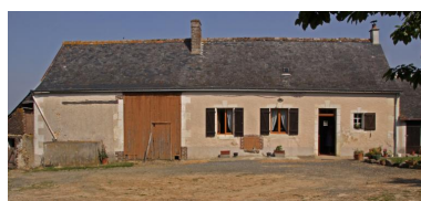
Maison 2 : façade antérieure sur cour. Phot. Jean-Baptiste Darrasse IVR52_20107200974NUCA
