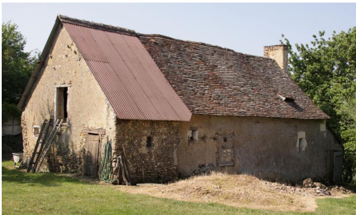
Maison 1 : vue de volume avec façade nord.
