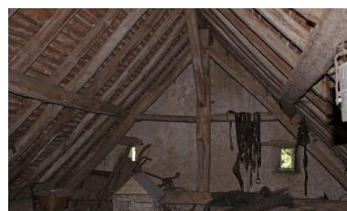
Maison 1 : charpente côté pignon ouest. Phot. Jean-Baptiste Darrasse IVR52_20107200981NUCA
