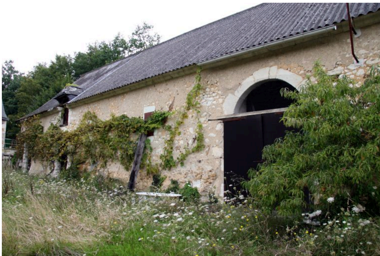
La grange : porte d'entrée.
