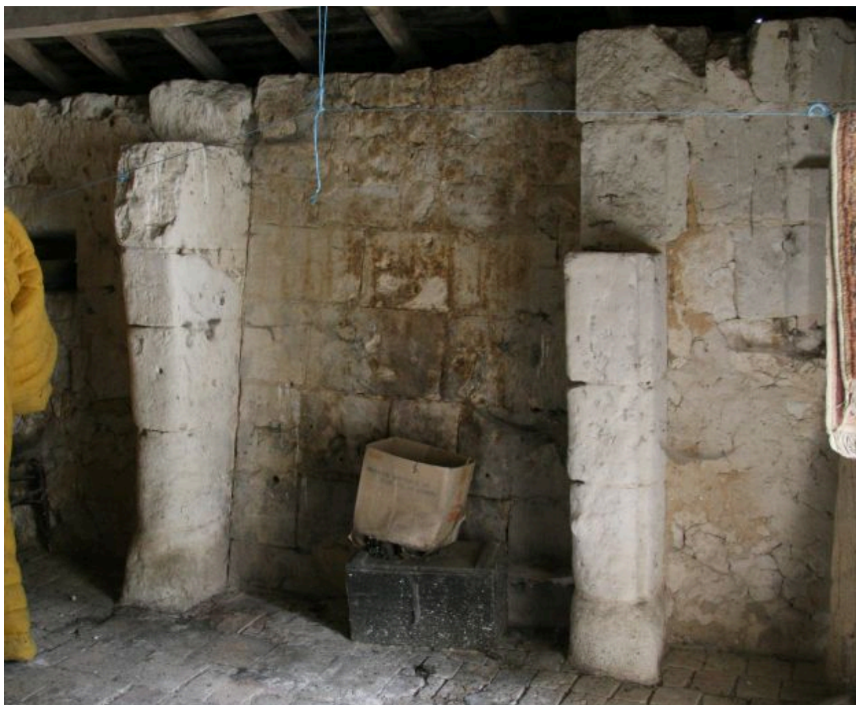
Tourelle, 1er étage : cheminée.
