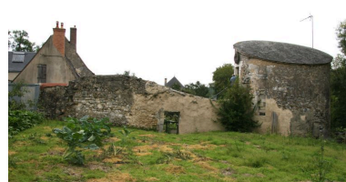
Mur ouest. Phot. Jean-Baptiste Darrasse IVR52_20077201577NUCA
