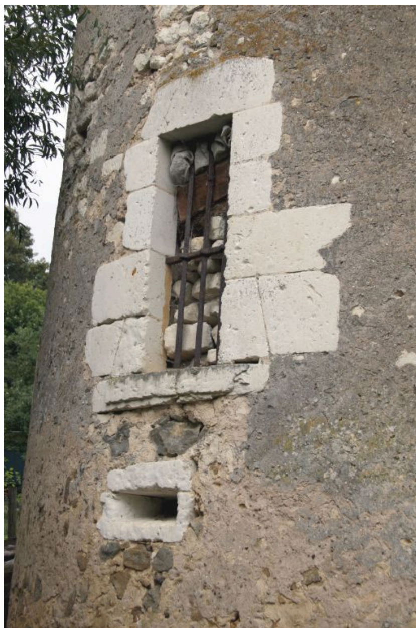
Tourelle, travée de baies : rez-de-chaussée.
