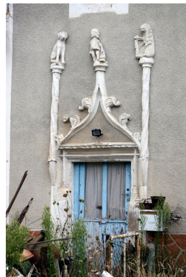
Le logis : porte d'entrée. Phot. Jean-Baptiste Darrasse IVR52_20077201580NUCA
