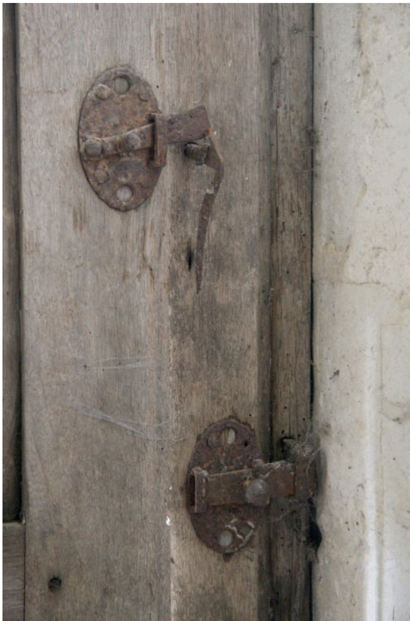
Tourelle, menuiserie : double targette de la fenêtre et du volet.
