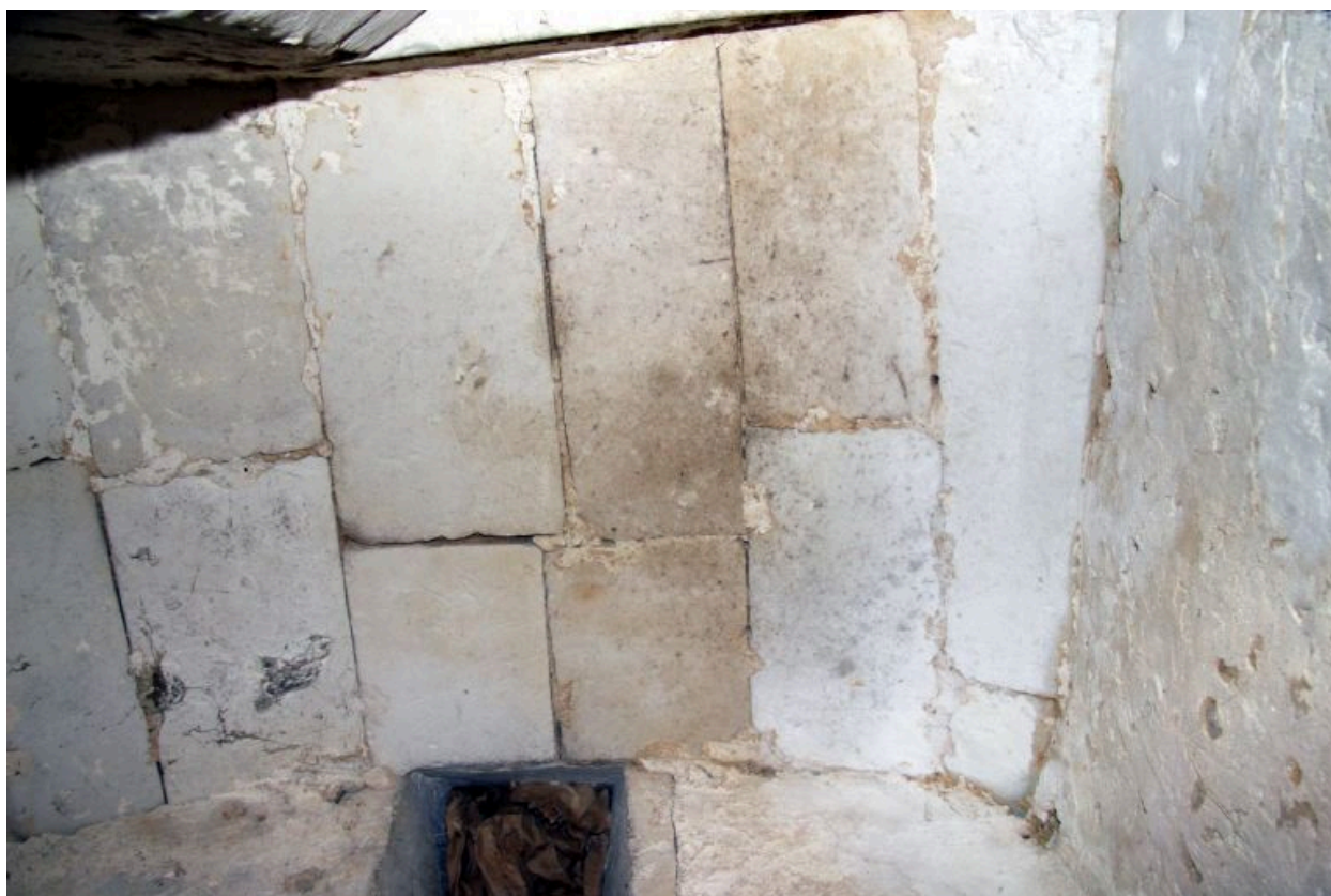
Tourelle, rez-de-chaussée, cabinet : voûte.
