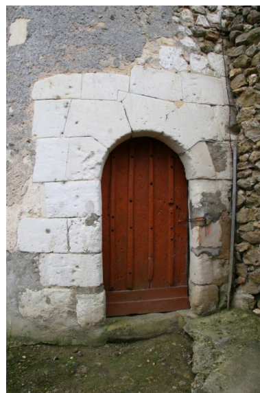
Tourelle : porte d'entrée. Phot. Jean-Baptiste Darrasse IVR52_20077201565NUCA
