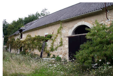
La grange : porte d'entrée. Phot. Jean-Baptiste Darrasse IVR52_20077201587NUCA
