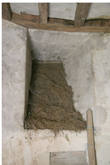
Tourelle, rez-de-chaussée, fenêtre haute. Phot. Jean-Baptiste Darrasse IVR52_20077201564NUCA
