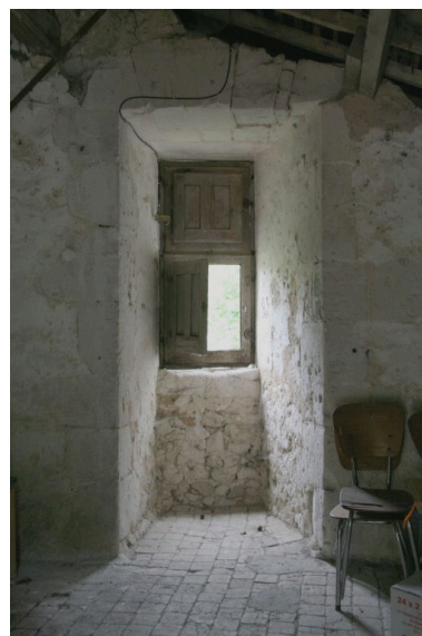
Tourelle, 1er étage, demi-croisée : menuiserie. Phot. Jean-Baptiste Darrasse IVR52_20077201570NUCA
