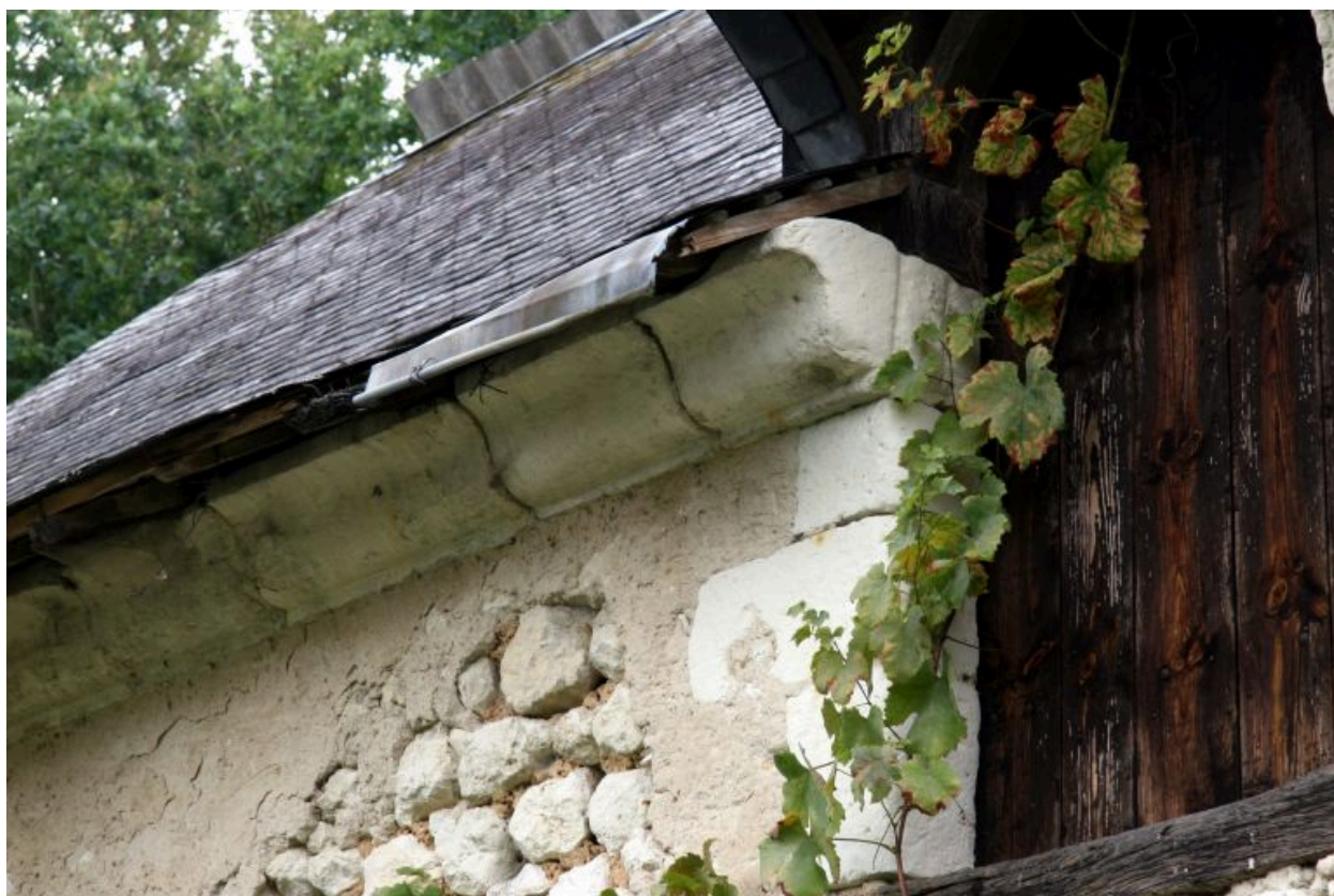
La grange : corniche.
