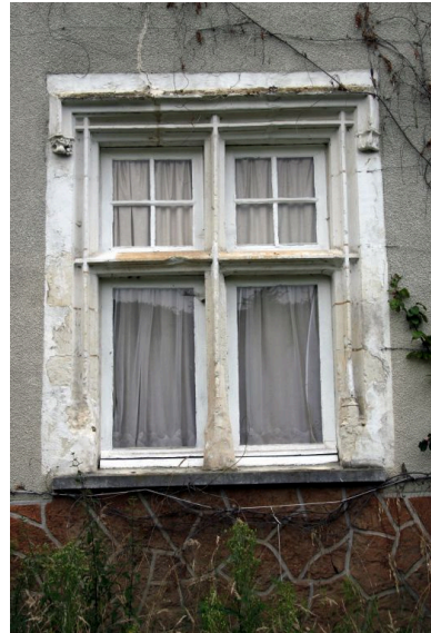
Le logis : croisée du rez-de-chaussée. Phot. Jean-Baptiste Darrasse IVR52_20077201583NUCA
