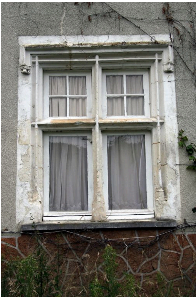
Le logis : croisée du rez-de-chaussée.
