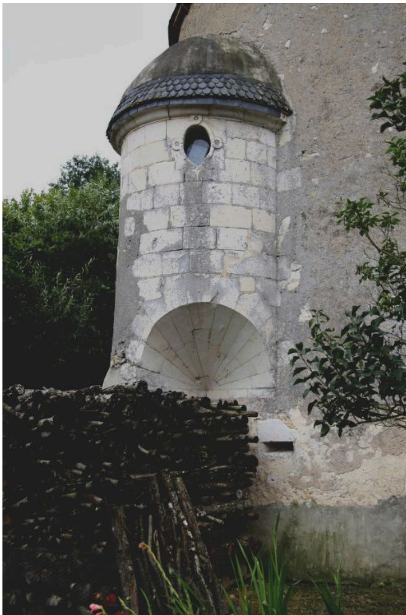
Tourelle : échauguette sur trompe.
