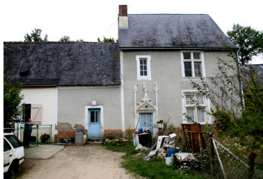
Le logis a perdu sa lucarne et la souche de cheminée. Phot. Jean-Baptiste Darrasse IVR52_20077201579NUCA
