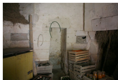
Tourelle, rez-de-chaussée : remarquer les bouches-à-feu de chaque côté. Phot. Jean-Baptiste Darrasse IVR52_20077201561NUCA
