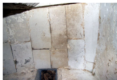
Tourelle, rez-de- chaussée, cabinet : voûte. Phot. Jean-Baptiste Darrasse IVR52_20077201562NUCA
