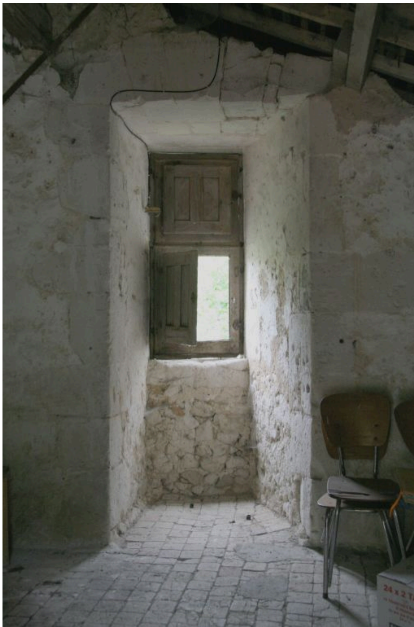
Tourelle, 1er étage, demi-croisée : menuiserie.
