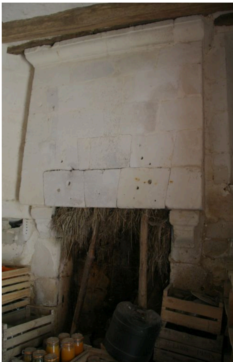
Tourelle, rez-de-chaussée : cheminée.
