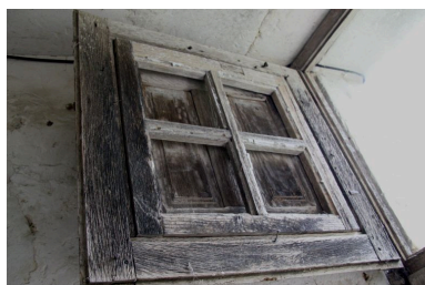
Tourelle, menuiserie : face externe. Phot. Jean-Baptiste Darrasse IVR52_20077201573NUCA
