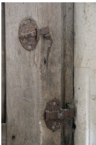
Tourelle, menuiserie : double targette de la fenêtre et du volet. Phot. Jean-Baptiste Darrasse IVR52_20077201572NUCA
