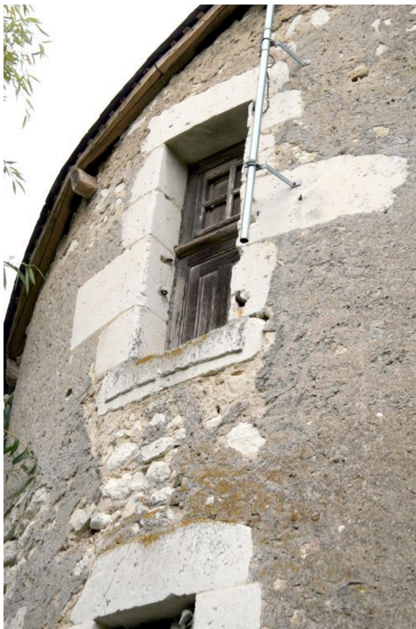
Tourelle, 1er étage : demi-baie.
