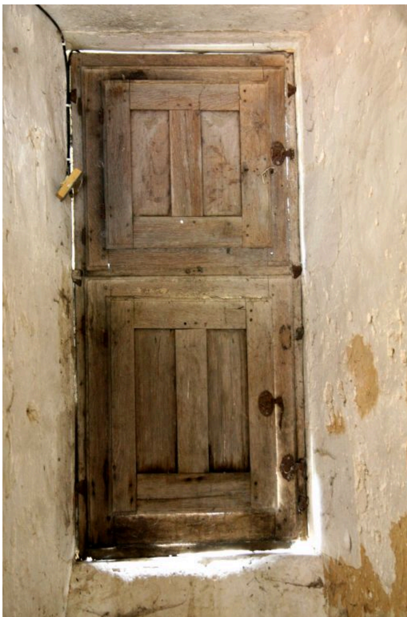
Tourelle, 1er étage : fenêtre avec volets.
