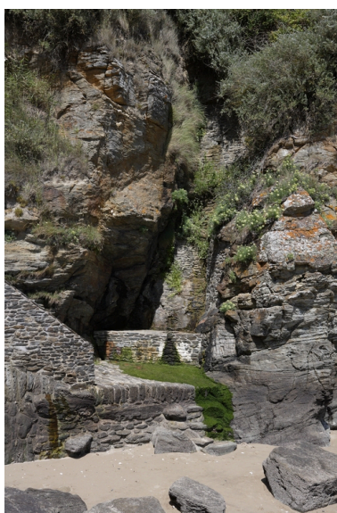
Ouvrage en pierre accueillant l'eau de source.
