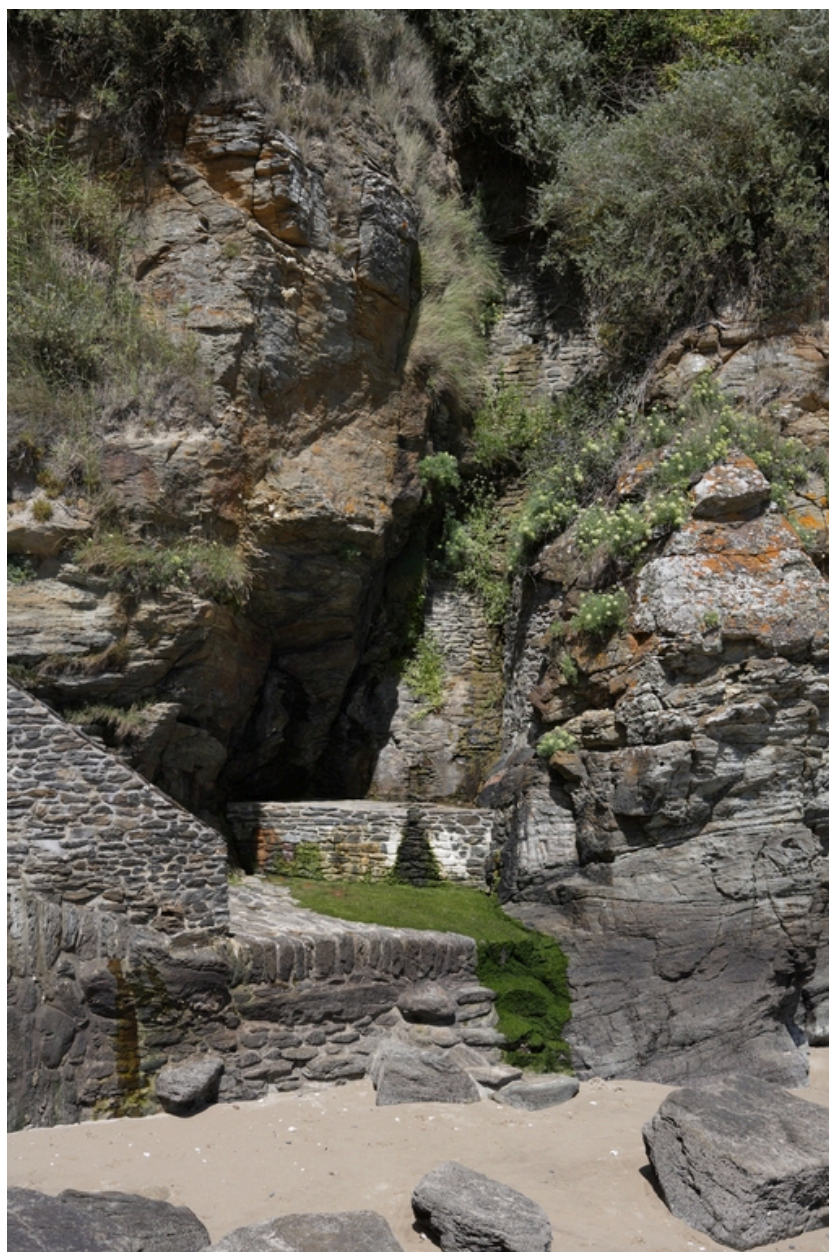
Ouvrage en pierre accueillant l'eau de source.
