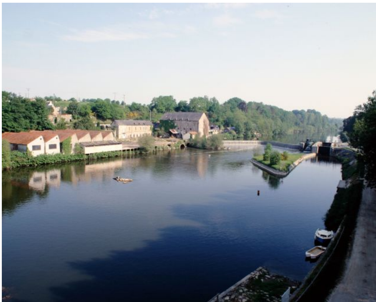
Vue d' ensemble du site depuis le pont de Rochefort : ancienne usine d'amiante, barrage, centrale hydroélectrique, canal d'accès à l'écluse, écluse, chemin de halage.
