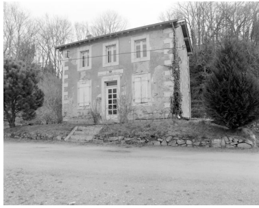
La maison éclusière. Phot. François Lasa IVR52_20025300394X
