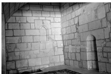
Rez-de-chaussée du 9, place des Diligences, pièce nord : niches
