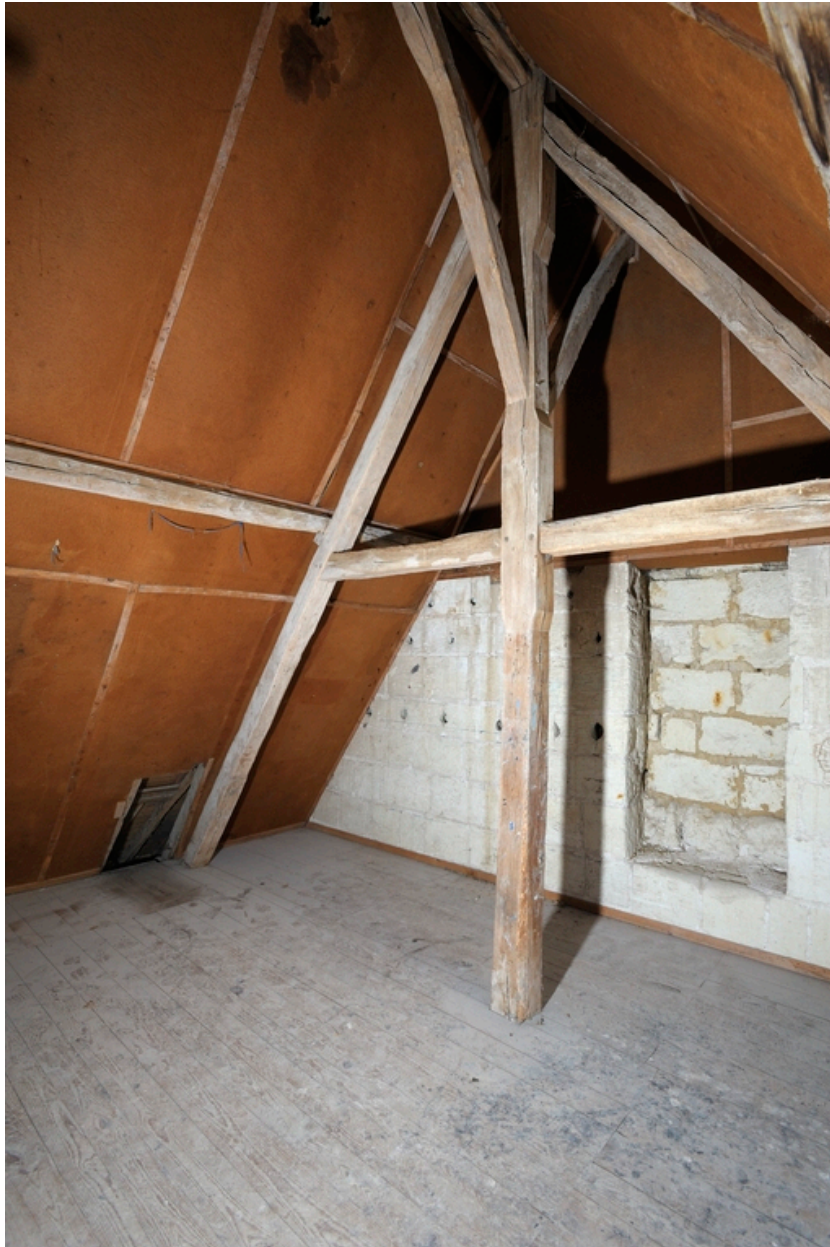
Ancienne chapelle nord (fin XVe siècle), comble. Charpente d'origine, à fermes et à pannes.
