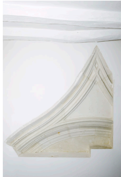
Ancienne nef : mouluration flamboyante (fin XVe) d'une arcade nord (obturée) qui ouvrait sur la chapelle nord. Phot. Bruno Rousseau IVR52_20124901078NUCA
