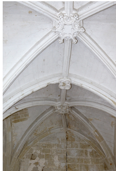
Ancienne chapelle nord (fin XVe siècle), étage. Voûtes d'ogives bombées. Phot. Bruno Rousseau IVR52_20134900542NUCA
