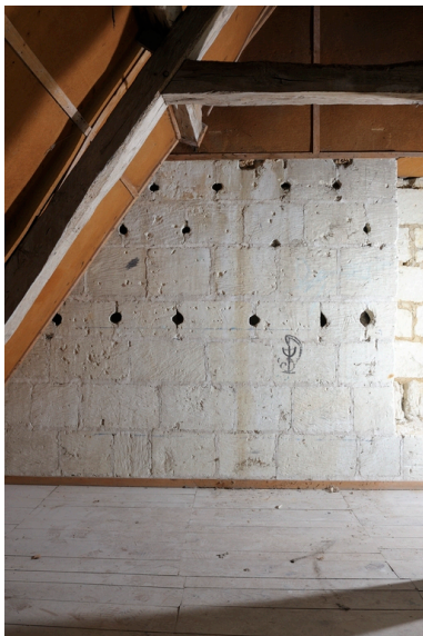
Ancienne chapelle nord (fin XVe siècle), comble, mur sud. Trous de boulin d'un pigeonier de la seconde moitié du XVe siècle. Phot. Bruno Rousseau IVR52_20134900939NUCA
