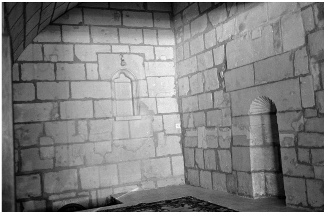
Rez-de-chaussée du 9, place des Diligences, pièce nord : niches sculptées de l'ancien clocher de la chapelle castrale (en 1979).
