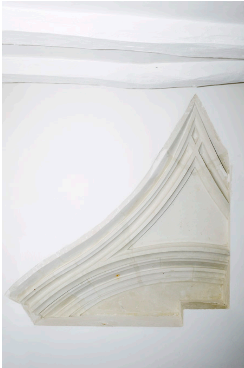
Ancienne nef : mouluration flamboyante (fin XVe) d'une arcade nord (obturée) qui ouvrait sur la chapelle nord.
