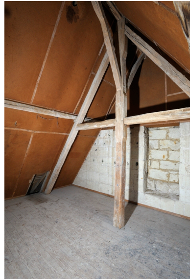
Ancienne chapelle nord (fin XVe siècle), comble. Charpente d'origine, à fermes et à pannes. Phot. Bruno Rousseau IVR52_20134900942NUCA
