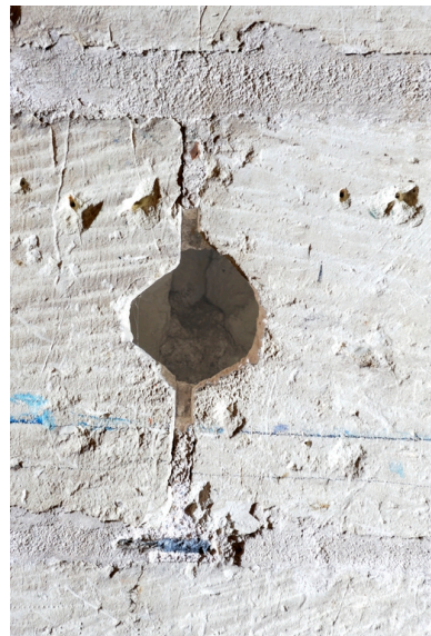
Ancienne chapelle nord (fin XVe siècle), comble, mur sud. Détail d'un trou de boulin. Phot. Bruno Rousseau IVR52_20134900941NUCA
