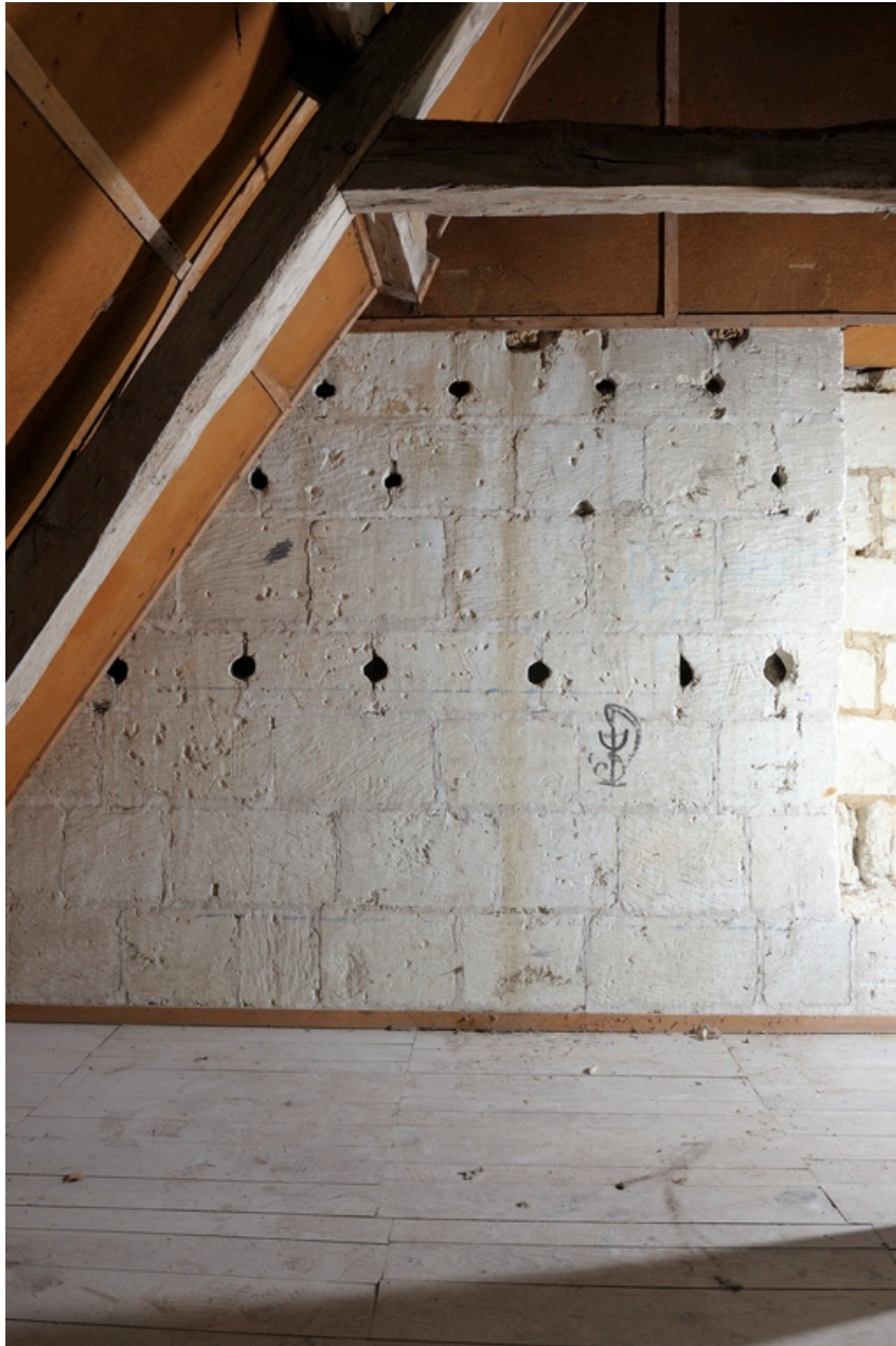
Ancienne chapelle nord (fin XVe siècle), comble, mur sud. Trous de boulin d'un pignonier de la seconde moitié du XVe siècle.
