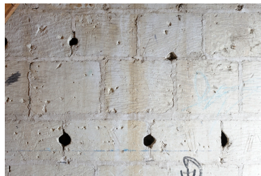
Ancienne chapelle nord (fin XVe siècle), comble, mur sud. Trous de boulin, percés dans les joints de l'appareil de tuffeau. Phot. Bruno Rousseau IVR52_20134900940NUCA
