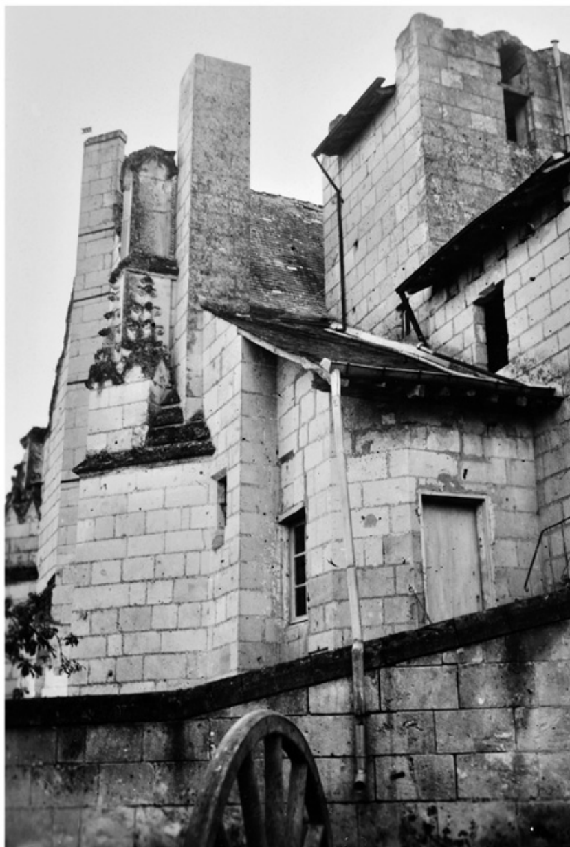
Façade nord (vers 1950-1952). Tirage photographique cliché réalisé vers 1950-1952 (?), 6x9cm noir et blanc.
