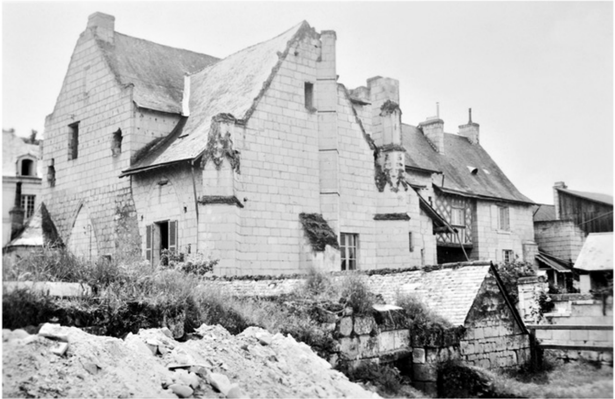
Façades nord et est (vers 1950-1952). Tirage photographique cliché réalisé vers 1950-1952 (?), 6x9 cm.
