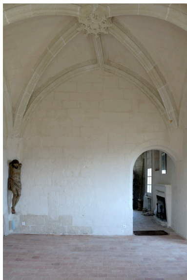
Ancienne chapelle nord (fin XVe siècle), étage. Mur ouest, avec coups de sabre correspondant au clocher (avec une baie obturée en bas à gauche) et à une ancienne porte (l'actuelle est tardive).
