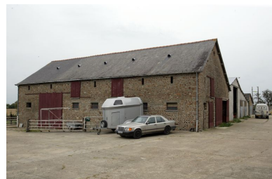
L'étable-grange vue depuis l'est. Phot. François Lasa IVR52_20055301520NUCA
