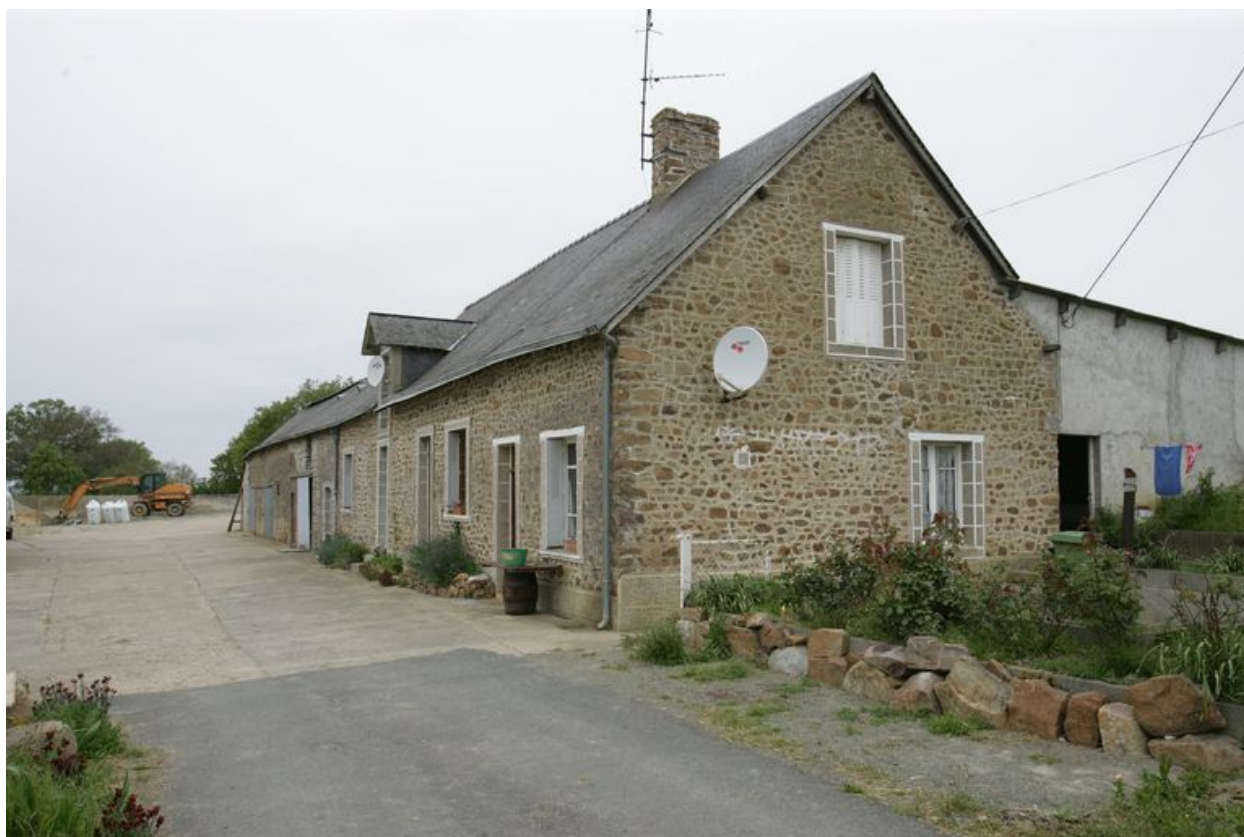
Le logis-étable vu depuis l'est.
