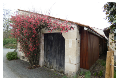
L'étable vue depuis le nord-ouest. Phot. Yannis Suire IVR52_20238500819NUCA
