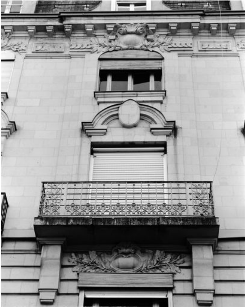
Elévation antérieure, 6e travée : baies des 3e, 4e et 5e niveaux.
